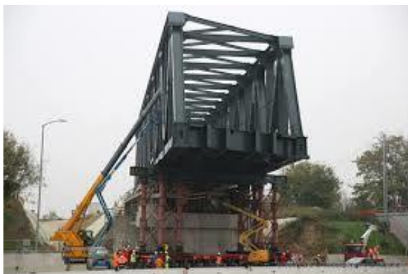
Esempio di varo del nuovo ponte della Bologna-Venezia sulla A14 Foto Gruppo FS Italiane
