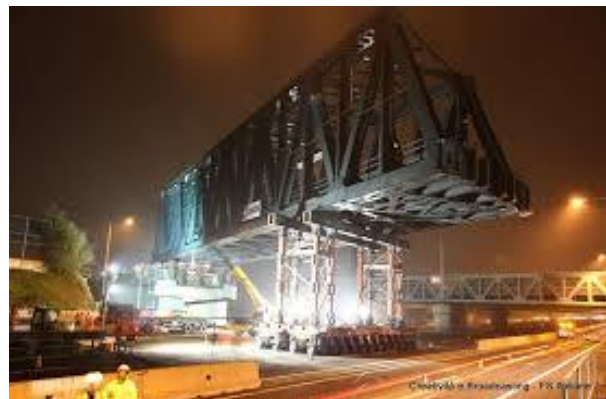
Esempio di varo del nuovo ponte della Bologna-Venezia sulla A14 Foto Gruppo FS Italiane
