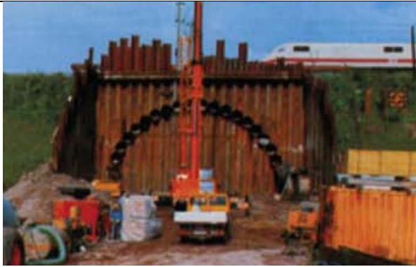
Realizzazione di calotta per sottopasso ferroviario
