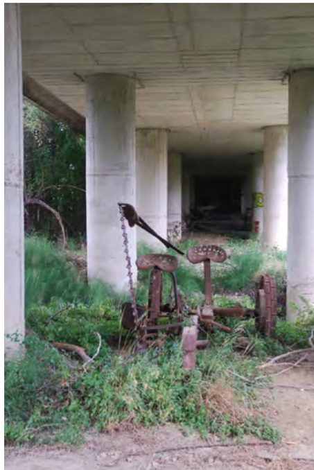
vista da sotto il viadotto
