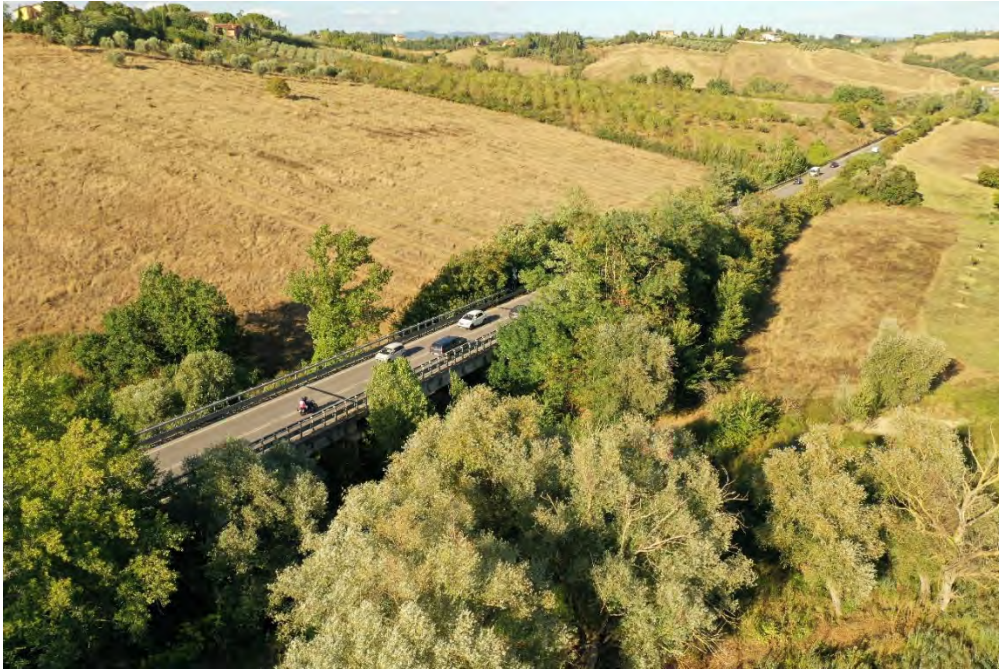
Vista aerea del viadotto delle Luglie (dir. Fano) con vegetazione ripariale del fosso delle Luglie ( Salix alba ), seminativi e oliveti
