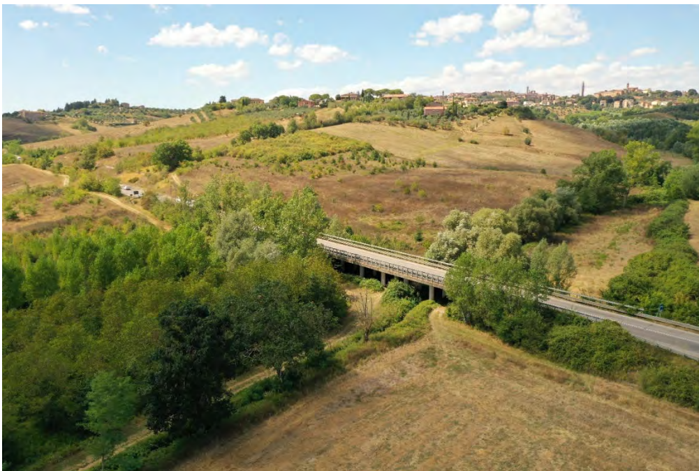
Vista aerea da sud del viadotto Valli, ben visibile la vegetazione ripariale con componente arborea di notevole interesse naturalistico ( Salix alba ), boscaglie di invasione a prugnolo a nord dell'infrastruttura e frutteto (Noce) a sud.
