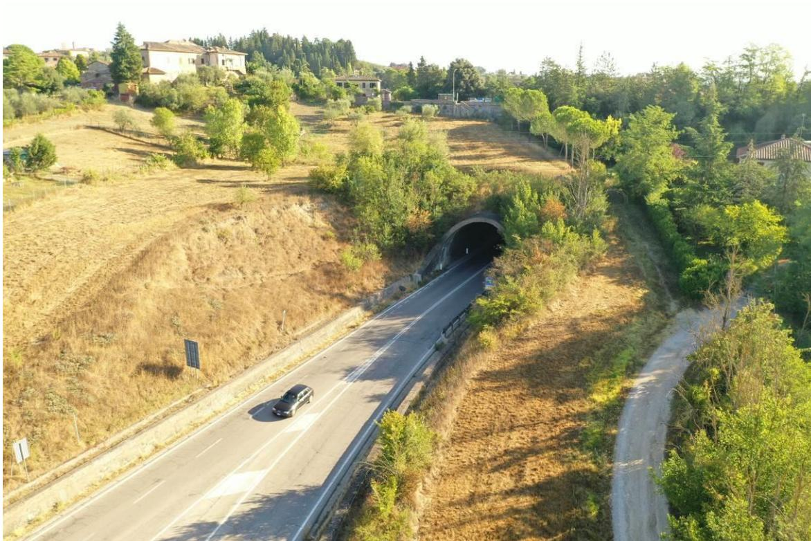
**Figura 17** – Orlo di scarpata antropica a ridosso dell'imbocco lato Grosseto della galleria S. Lazzerò, parzialmente in evoluzione (immagine da drone, 2020)
