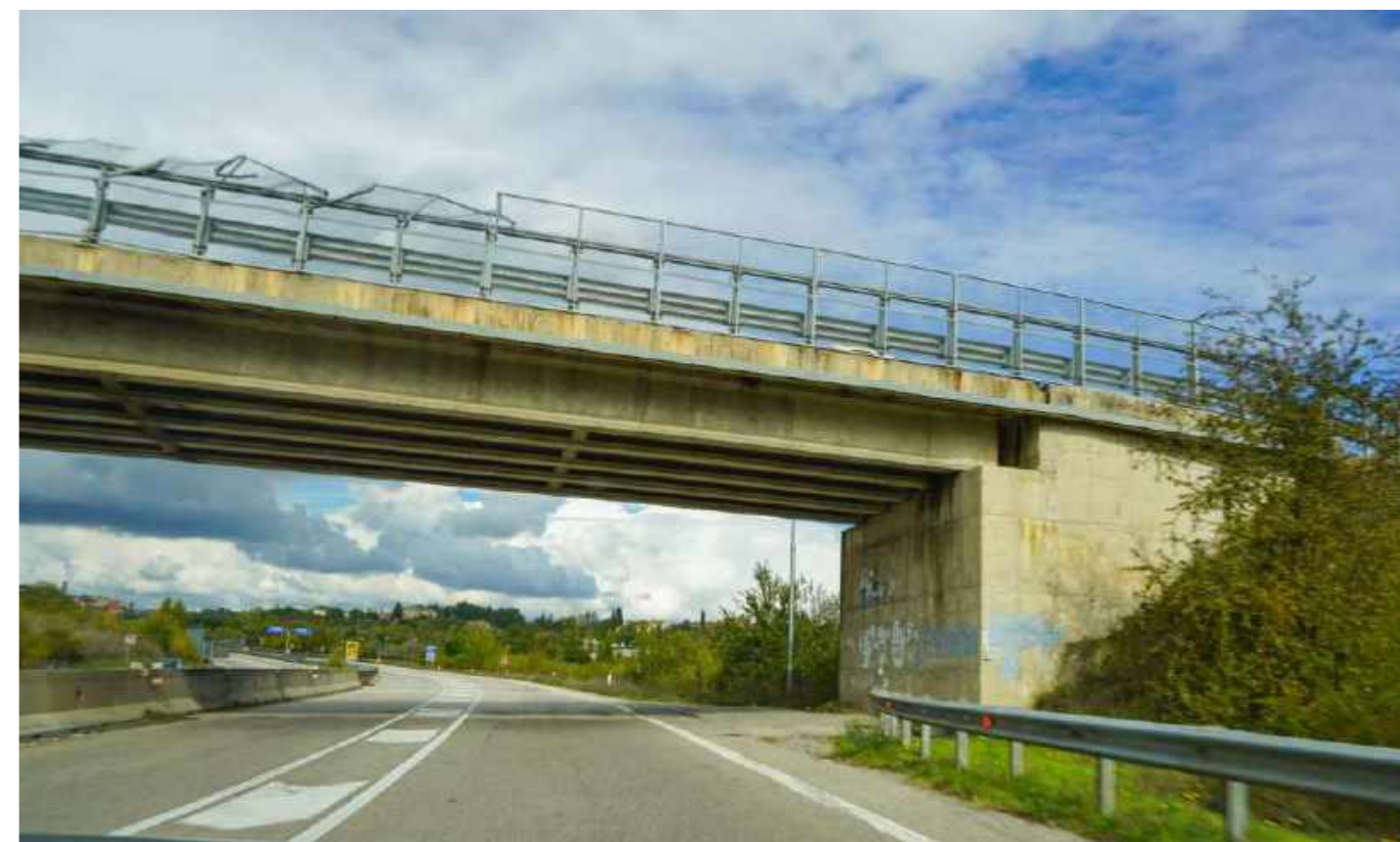
Vista dall'infrastruttura il cavalcavia esistente.
