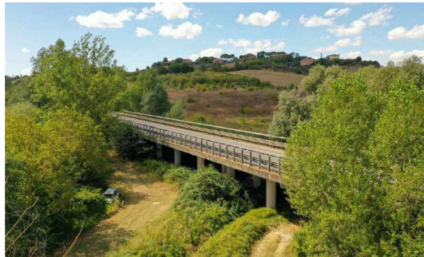
Viadotto Valli esistente.
