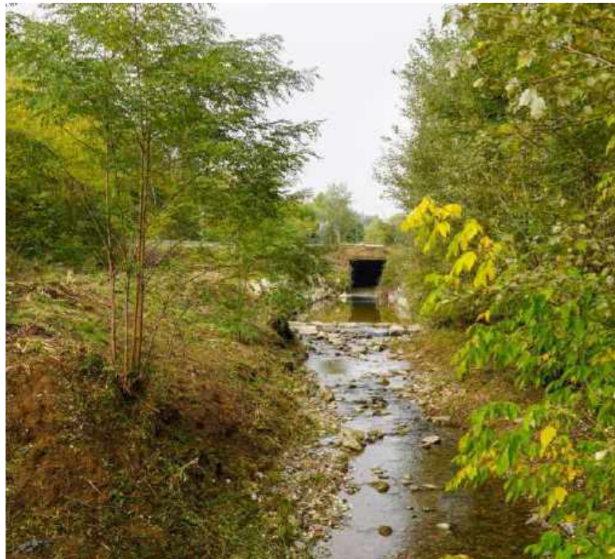
Fosso Riluogo nei pressi dell'abitato di Ruffolo. Data: ottobre 2020.
