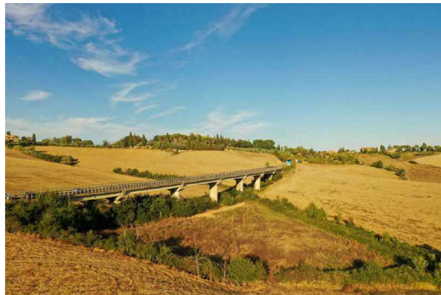
Viadotto Ribucciano e sbocco della Galleria Bucciano. Punto di ripresa : S-O. Immagine aerea, agosto 2020.
