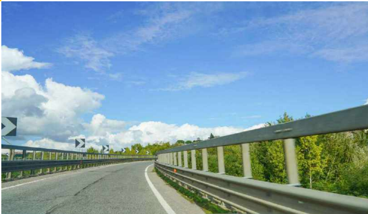
Vista dall'infrastruttura esistente in corrispondenza del Viadotto Tressa, direzione Fano.
