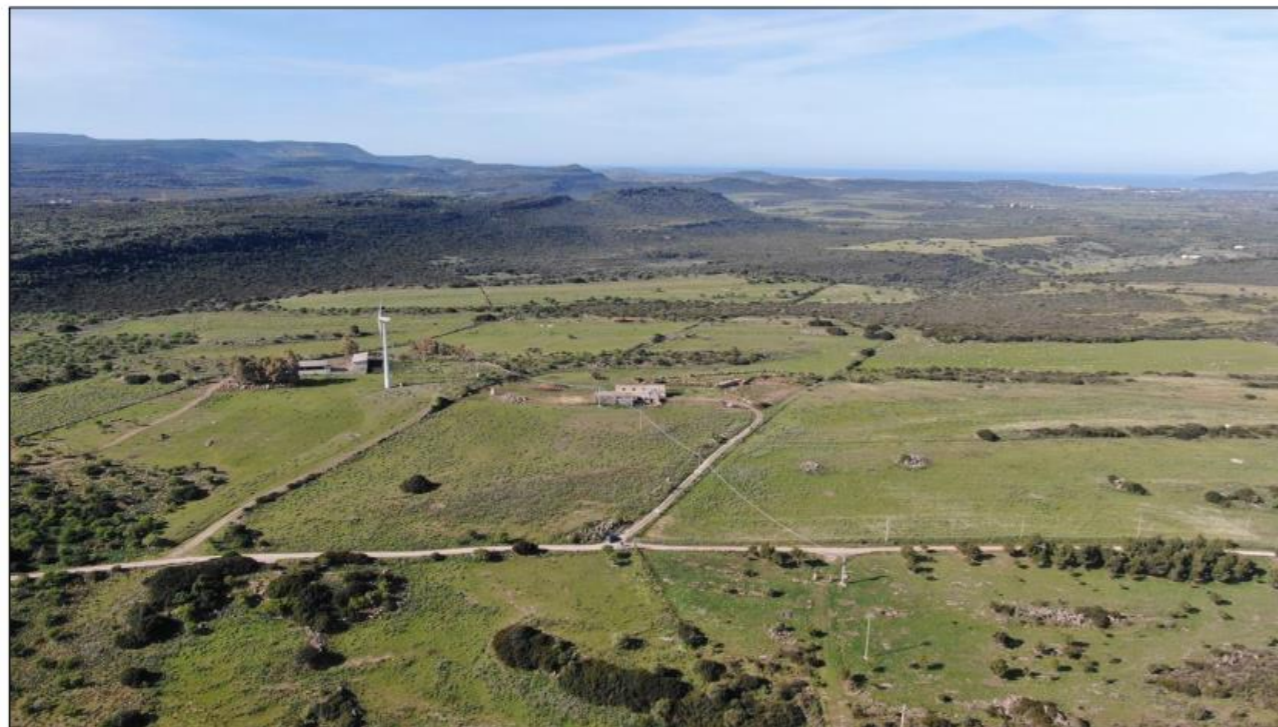
Vista generale da drone – direzione Sud Est
