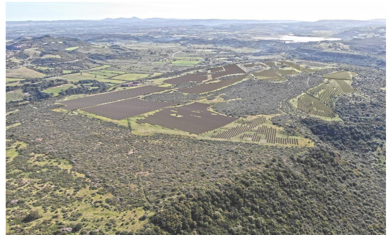
Area nord – impianto su Monte Siseri
