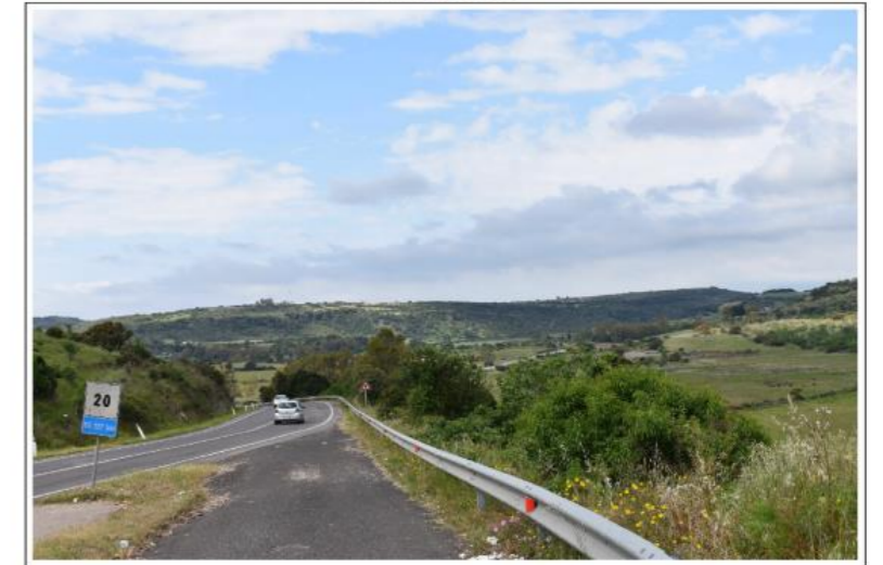
Vista dal km 20 della S.S. 127 bis - Stato di fatto
