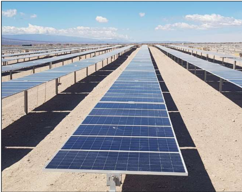
Foto della struttura di supporto di progetto
