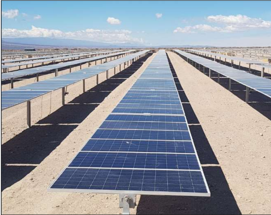
Foto della struttura di supporto di progetto
