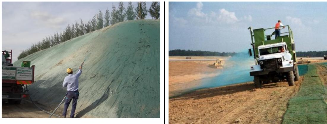
**Figura 24 – Esempi applicativi per l'idrosemina, su superficie inclinata o piana. Tale tecnica offre una maggior garanzia sulla germinabilità del seme per la presenza di sostanze stimolanti e protettive**
