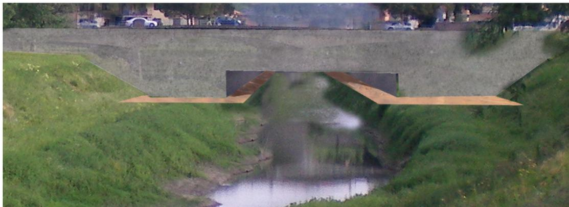
Figura 21 - Fotoinserimento di scatolare idraulico con passerelle laterali poggianti sugli argini. Tipologico adottato nella tratta 2B.
