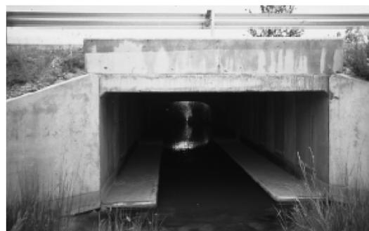
Figura 20 - Esempi di scatolari con passerelle laterali per il passaggio di fauna di piccole dimensioni.
