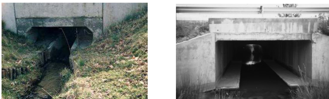
Figura 8 - Esempi di scatolari con passerelle laterali per il passaggio di fauna di piccole dimensioni.
