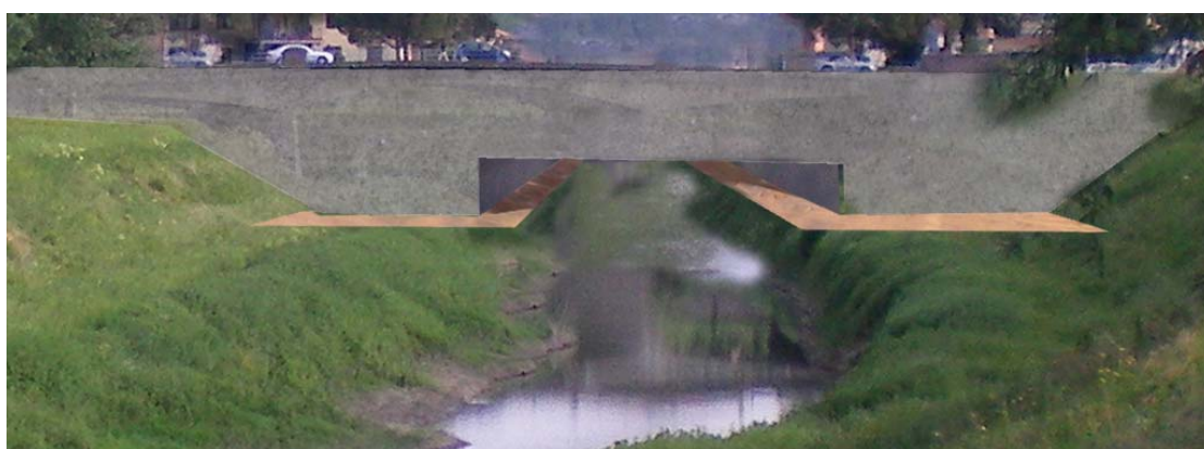
Figura 8 - Esempi di scatolari con passerelle laterali per il passaggio di fauna di piccole dimensioni.
