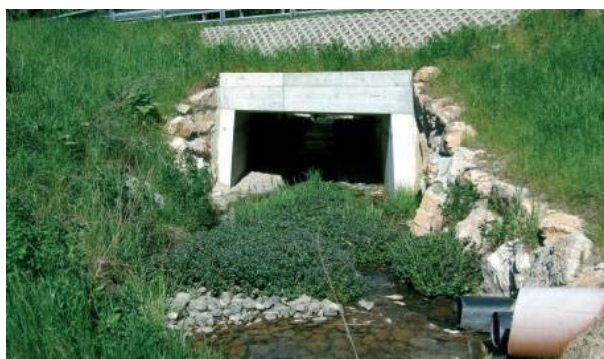
Figura 7 - Esempi di come un sottopasso costruito a fini idraulici possa essere usato dalla fauna di taglia media e piccola.
