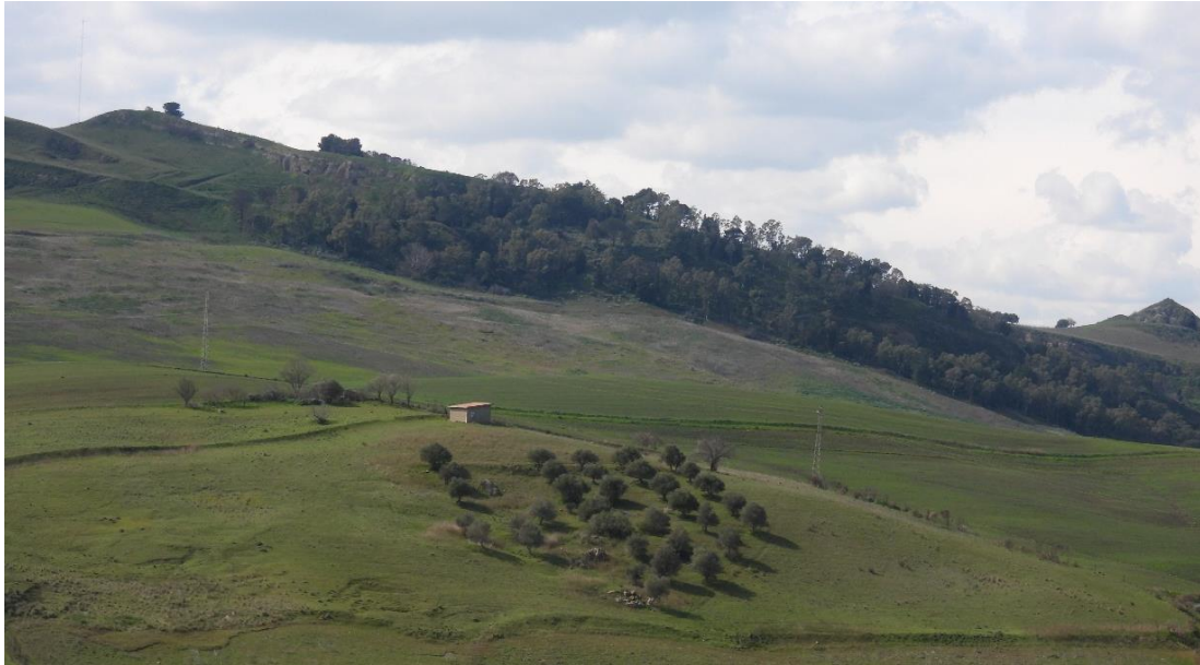
Figura 26 - vista dalla zona di pertinenza della WTG.03
