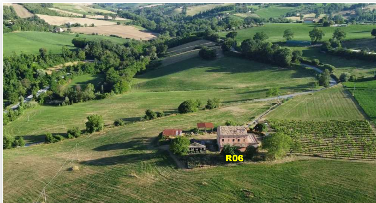
Figura 3.11 Ricettore R06 – attualmente oggetto di lavori di recupero edilizio; visibile la SP53 che discende verso il fondovalle
