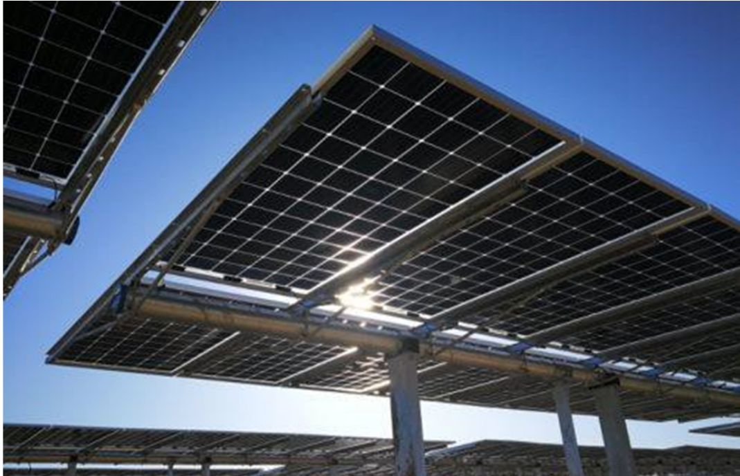
Figura 3.2: Esempio di struttura a tracker monoassiale
