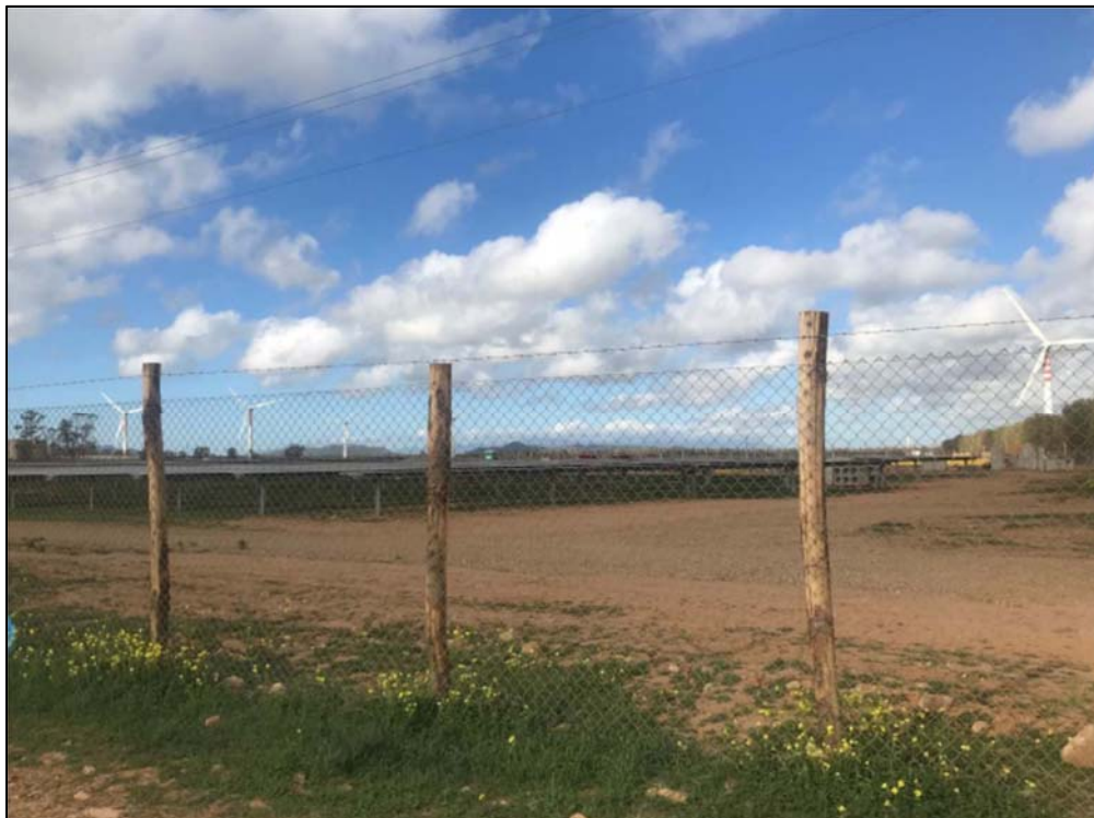
Figura 41 – Esempio di recinzione
