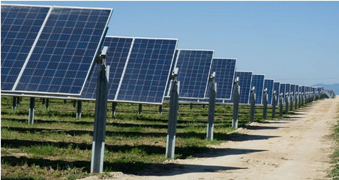
Fig. 2.3.3 – Immagine esemplificativa di inseguitori mono-assiali e moduli FV
