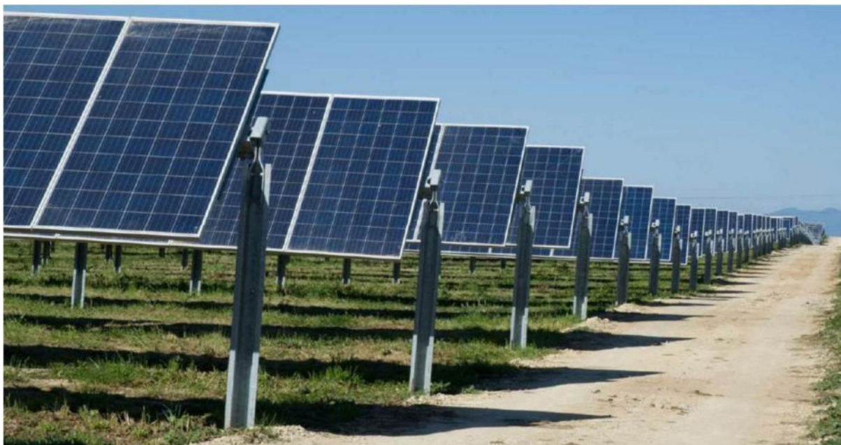
Fig. 3.2.11 – Immagine esemplificativa di inseguitori mono-assiali e moduli FV
