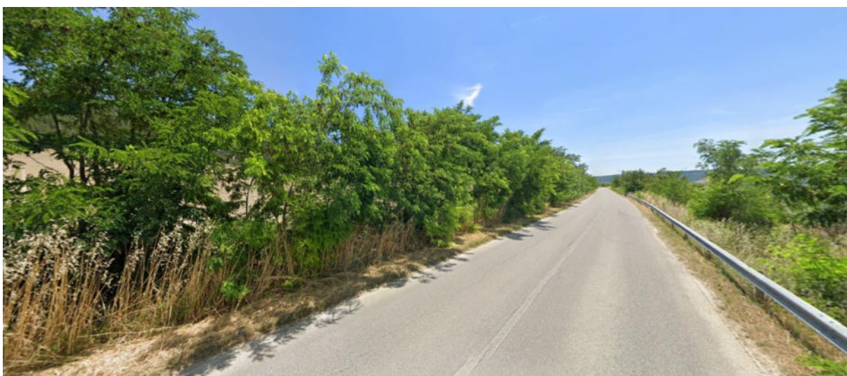
Fig.7.1.3 - Vista in direzione sud della macro-area 1 in un tratto con vegetazione di margine (fonte Google)
