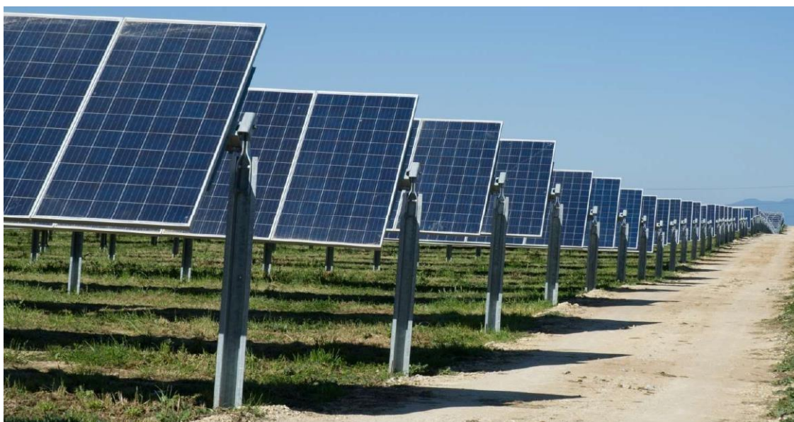
Figura 3 - immagine esemplificativa di inseguitori mono-assiali in configurazione 1P (fonte: ConvertItalia)
