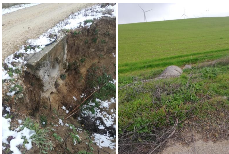
Figura 4 Strutture rilevate in sito lungo le aste A4 (a sinistra) e A5 (a destra).
