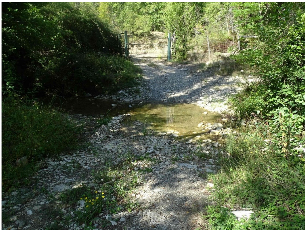
Figura 6.1.5 – Guado esistente sul fossa della Mulinaccia
