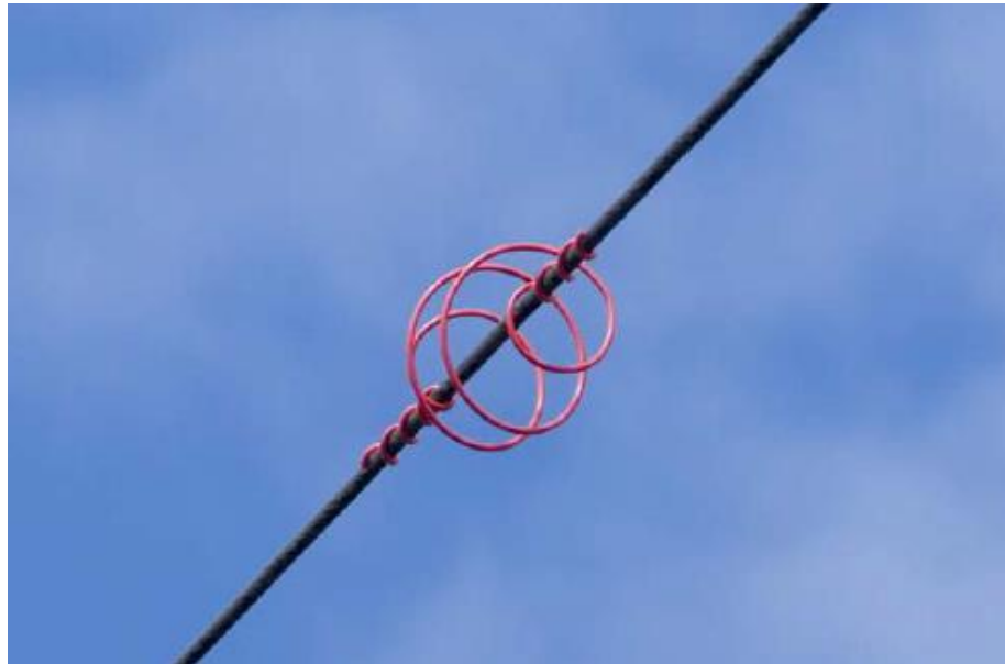
Figura 8-a. Spirale colorata in plastica per la segnalazione dei cavi
