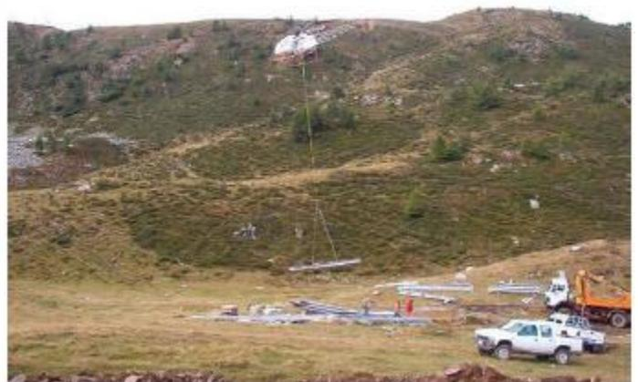
Figura 4: esempio di trasporto e montaggio carpenteria metallica del sostegno con elicottero.
