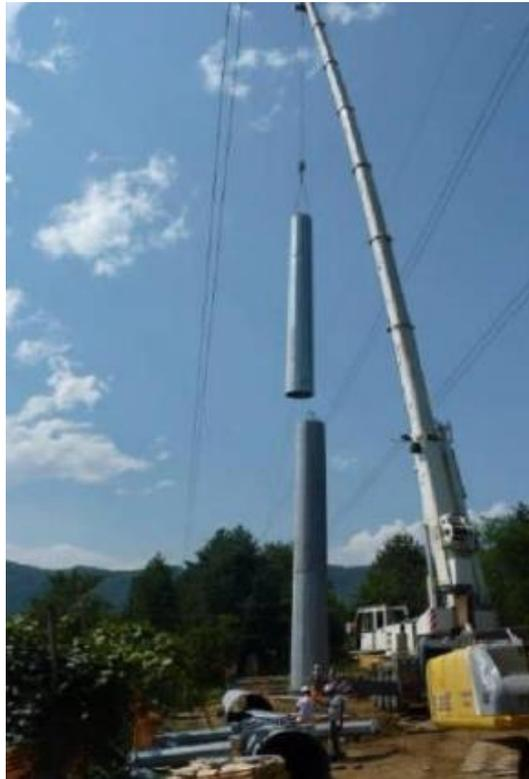
Figura 3: esempio di montaggio sostegno a palo con autogrù (a sinistra).
