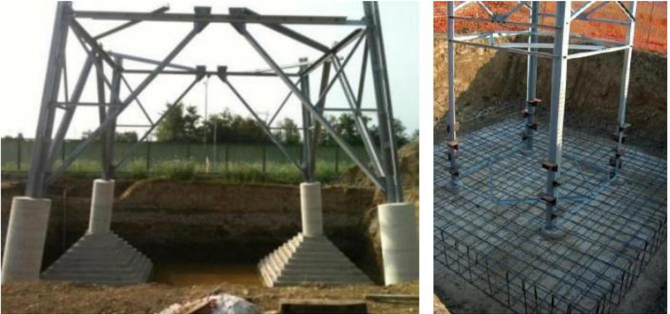
Figura 2: esempio di scavo e fondazione a piedini separati (a sinistra) e a blocco unico (a destra).
