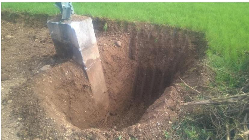
Figura 5. Esempio di rimozione della fondazione superficiale di un sostegno a traliccio in area agricola. Dopo aver separato il ferro di armatura e il moncone di base del sostegno, il calcestruzzo demolito, qualificato come rifiuto, dovrà essere trasportato in discariche autorizzate.
