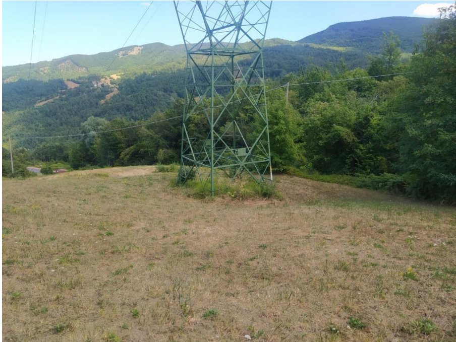
Figura 7-1 Rilievo fotografico n. 44 presso il sostegno n. 120
