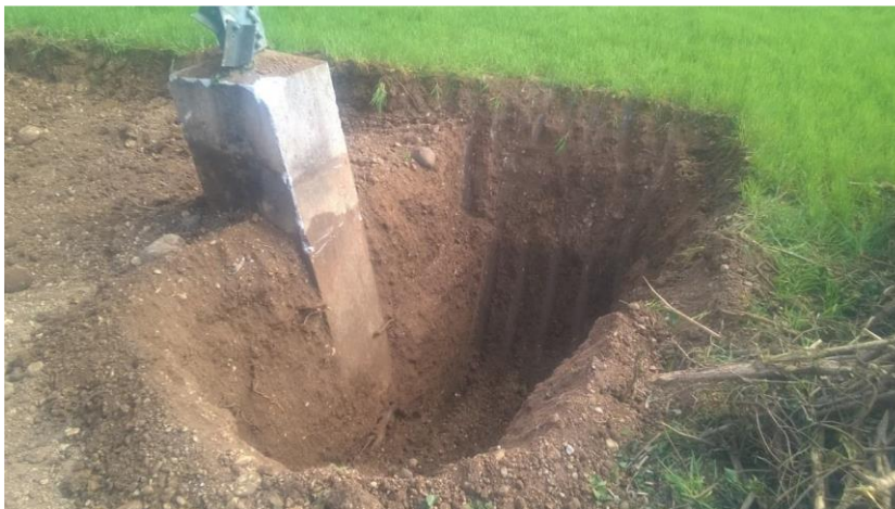
Figura 2-5. Esempio di rimozione della fondazione superficiale di un sostegno a traliccio in area agricola. Dopo aver separato il ferro di armatura e il moncone di base del sostegno, il calcestruzzo demolito, qualificato
