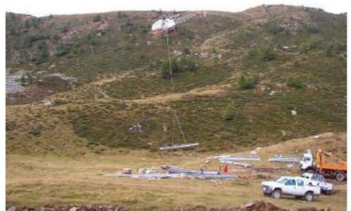
Figura 2-4: esempio di trasporto e montaggio carpenteria metallica del sostegno con elicottero.
