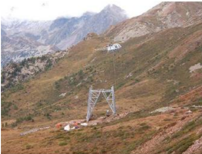
Figura 2-4: esempio di trasporto e montaggio carpenteria metallica del sostegno con elicottero.
