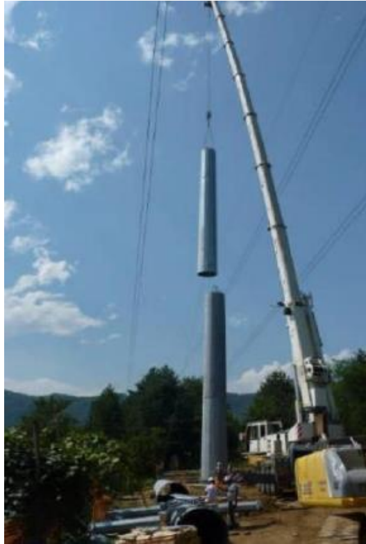
Figura 2-3: esempio di montaggio sostegno a palo con autogru (a sinistra).
