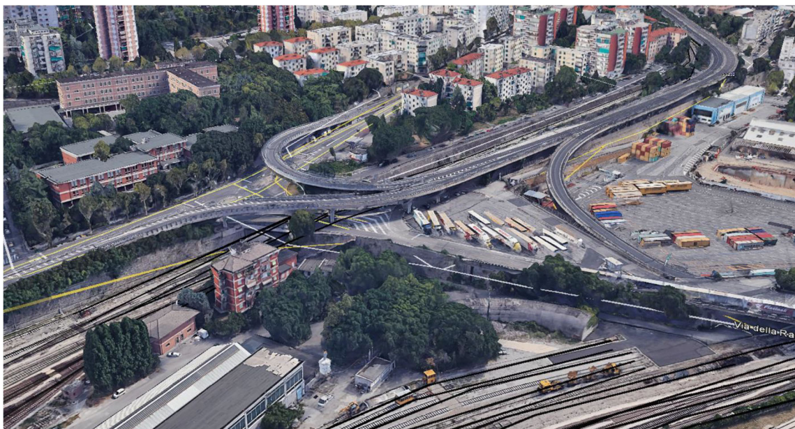
Figura 9 - Vista d’insieme della specifica area di intervento
