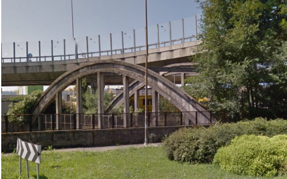
Figura 8 - Stato attuale dell'opera
