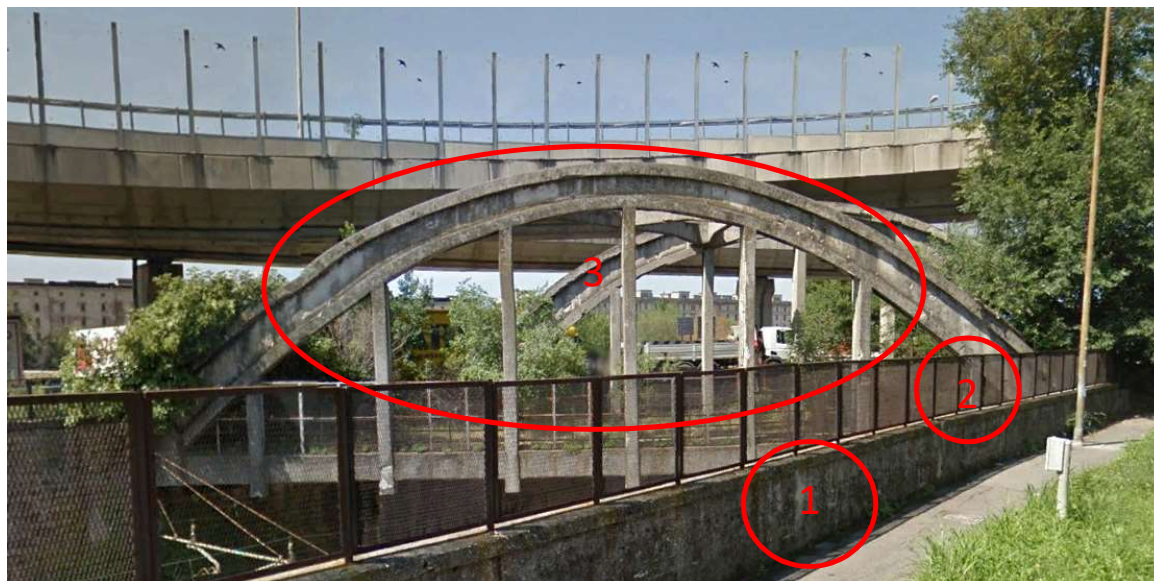
Figura 9-3: Demolizione ponte ad arco in C.A.: 1) Parapetto in muratura 2) Recinzione metallica 3) Ponte ad arco in C.A.. Non visibile, sotto al parapetto, il muro in pietra della trincea ferroviaria
