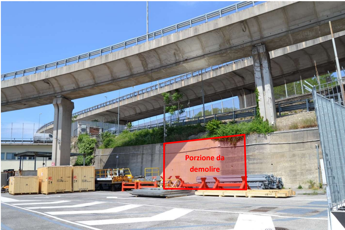
Figura 9-8: Fase "2" - muro controterra da demolire
