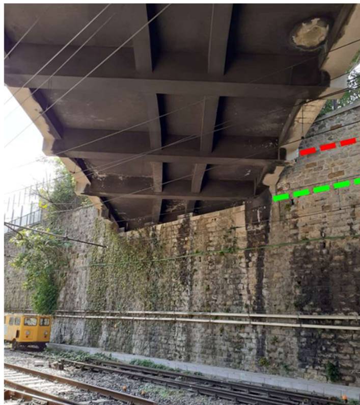
Figura 10-5 - Dettaglio delle due differenti altezze di demolizione
