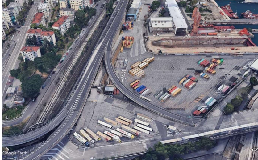
Figura 5-5: area dell'intervento – vista a Est
