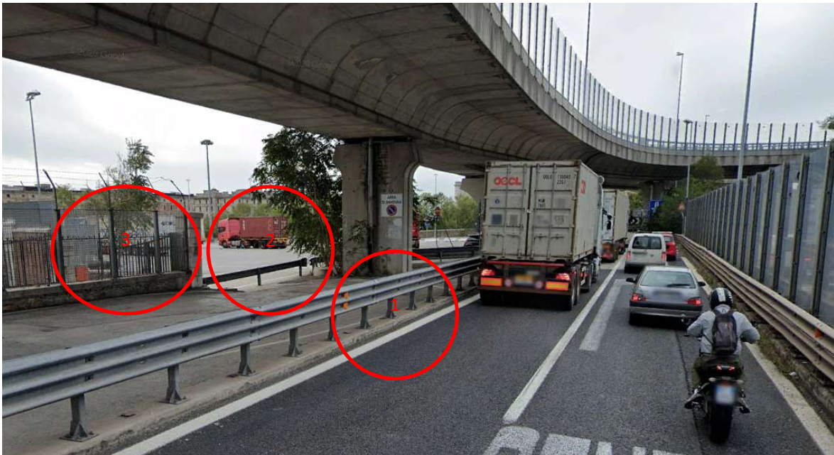
Figura 9-1: Viabilità provvisoria: 1) Barriera di sicurezza stradale e sottostante cordolo di protezione della SS202; 2) Barriera di sicurezza stradale e sottostante cordolo di protezione della rampa di accesso al porto; 3) Muro in pietra sottostante le due recinzione più alta con filo spinato e dietro si può scorgere la recinzione alta 1,50m. A fianco il pilastro in c.a. su cui si innesta il cancello in ferro battuto. Davanti al cancello, in arancione, si nota la colonnina della barra di accesso automatica
