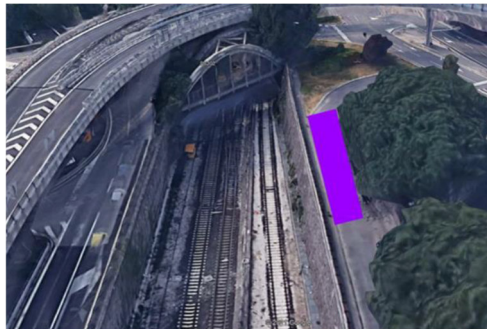
Possibile posizione per demolizione
