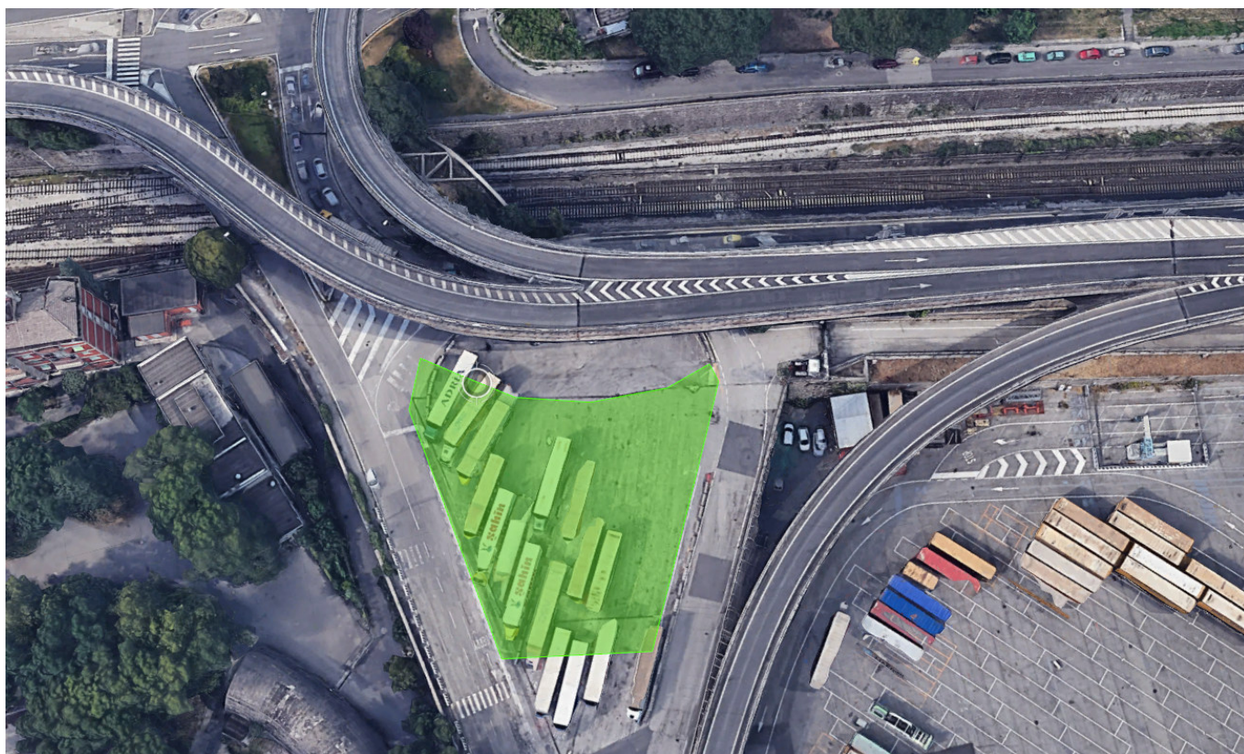
Vista aerea CO.01
