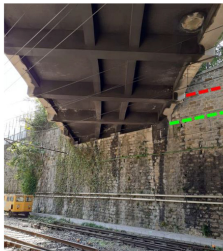
Dettaglio delle due differenti altezze di demolizione
