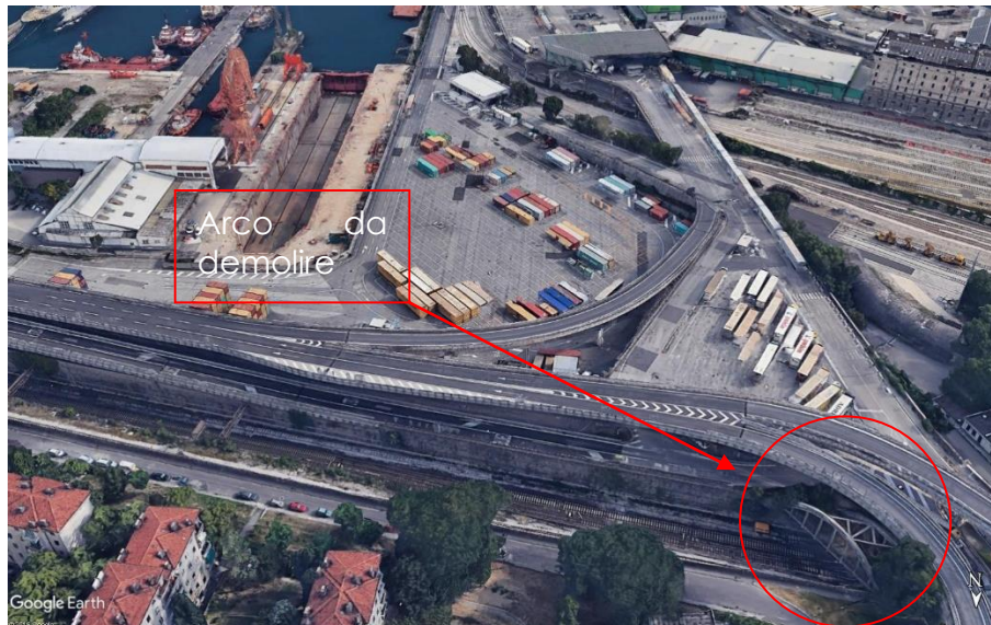
Figura 3: vista Sud Dell'intervento
