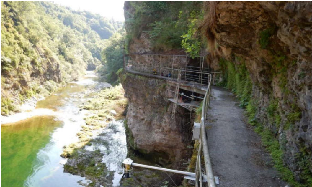
Figura 24 – Passerella di accesso, oggetto di intervento di sostituzione.
