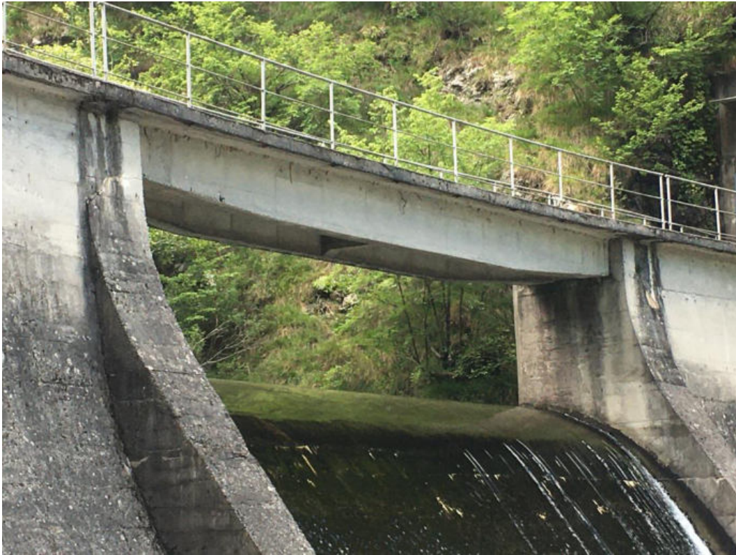
Figura 23 – Vista della passerella sullo sfioratore, oggetto di intervento di sostituzione
