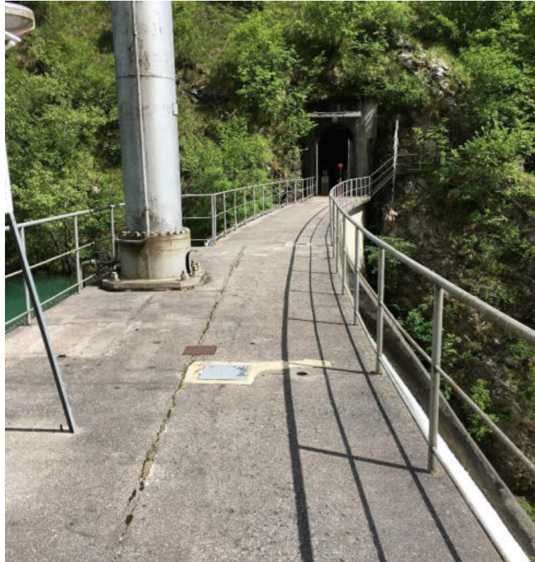
Figura 22 – coronamento della diga
