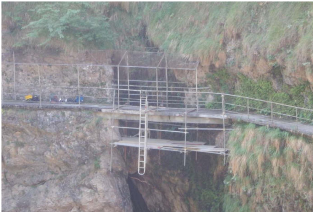
Figura 25 – Vista frontale della passerella di accesso, oggetto di intervento
