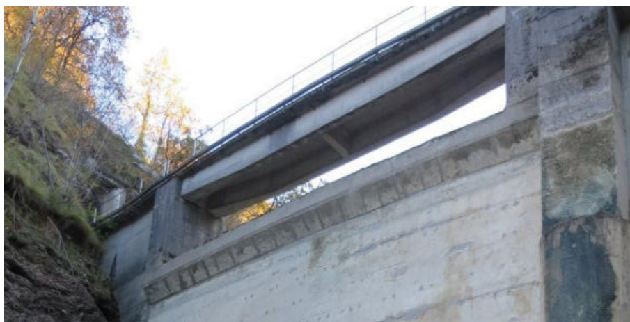
Figura 1 – vista da monte della passerella esistente
