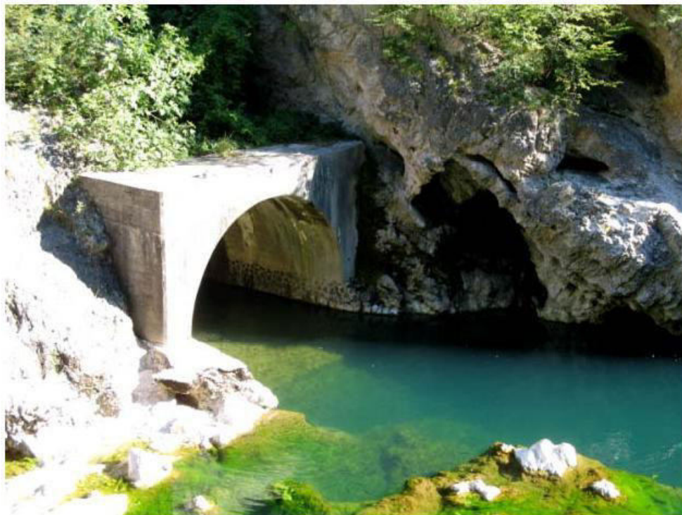
Sbocco dello scarico di fondo (in sponda sinistra)
