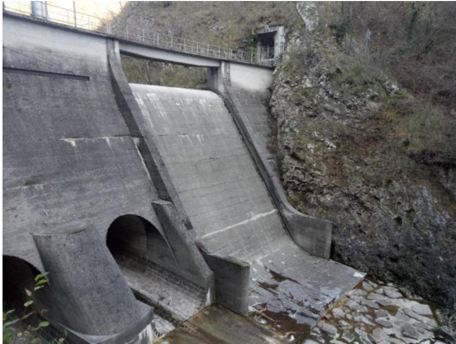
Passerella attuale in c.a. sullo sfioratore della diga
