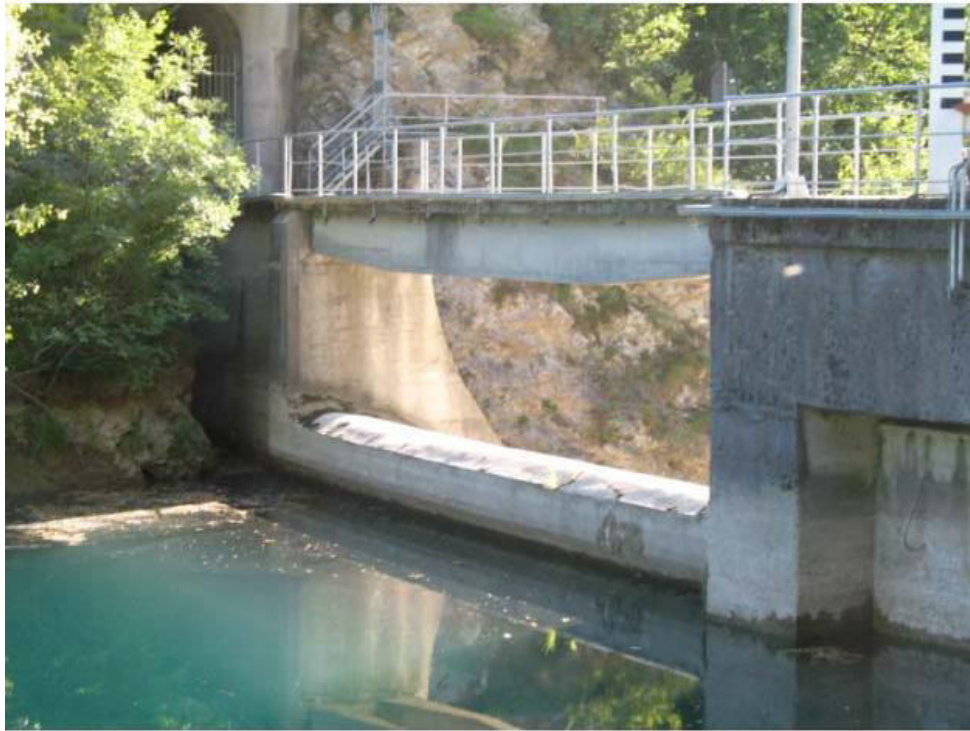
Soglia dello scarico di superficie
