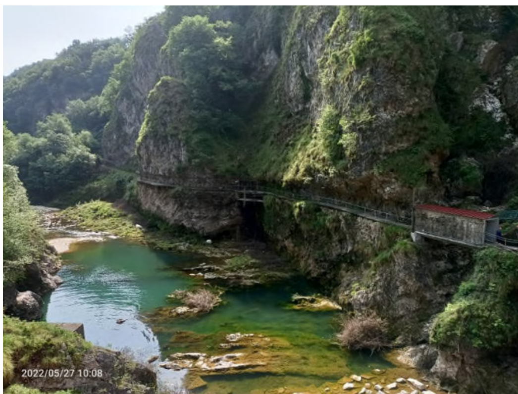
Vista del percorso di accesso alla diga
