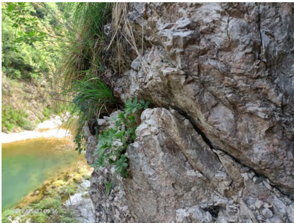
Fratturazione in corrispondenza dell'appoggio
