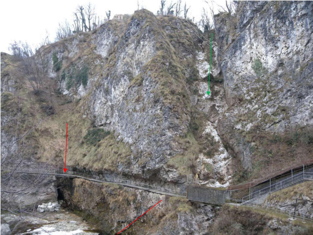
Foto 1: percorso di accesso alla centrale idroelettrica. La freccia indica il tratto in passerella sospesa da consolidare. La linea l'andamento della stratificazione. In verde il canale della confluenza del rio Brentegnan con l'Astico
