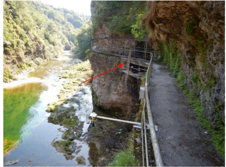
Foto 2: tratto da consolidare. La freccia indica il masso detensionato della foto successiva
