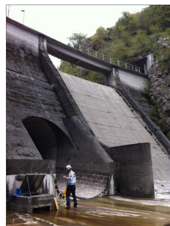
VISTA DA VALLE DELLA PASSERELLA DA SOSTITUIRE
