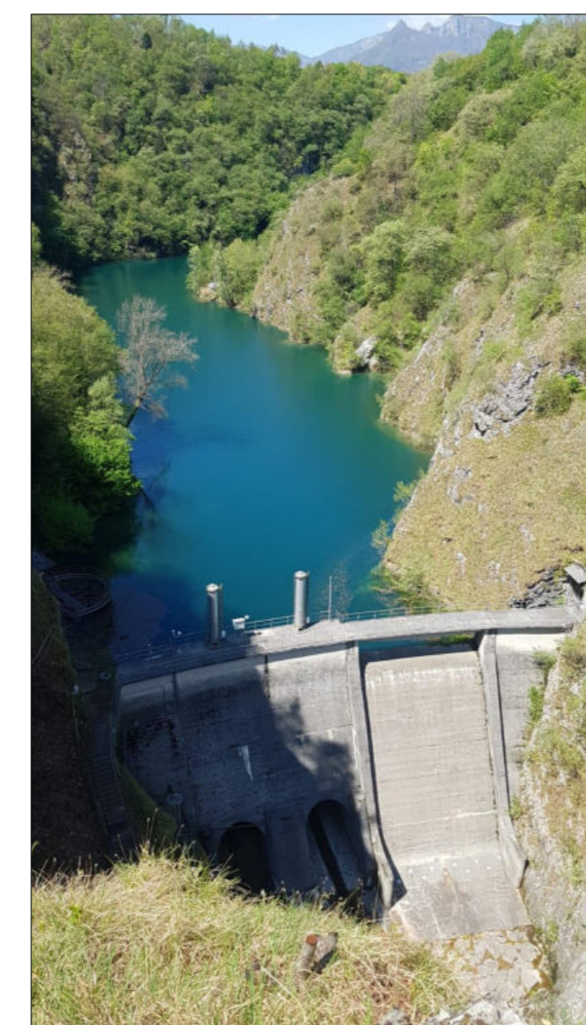
VISTA DELLA DIGA DALL'ALTO foto ritratta durante le operazioni di disaggio della parete rocciosa in sponda destra
