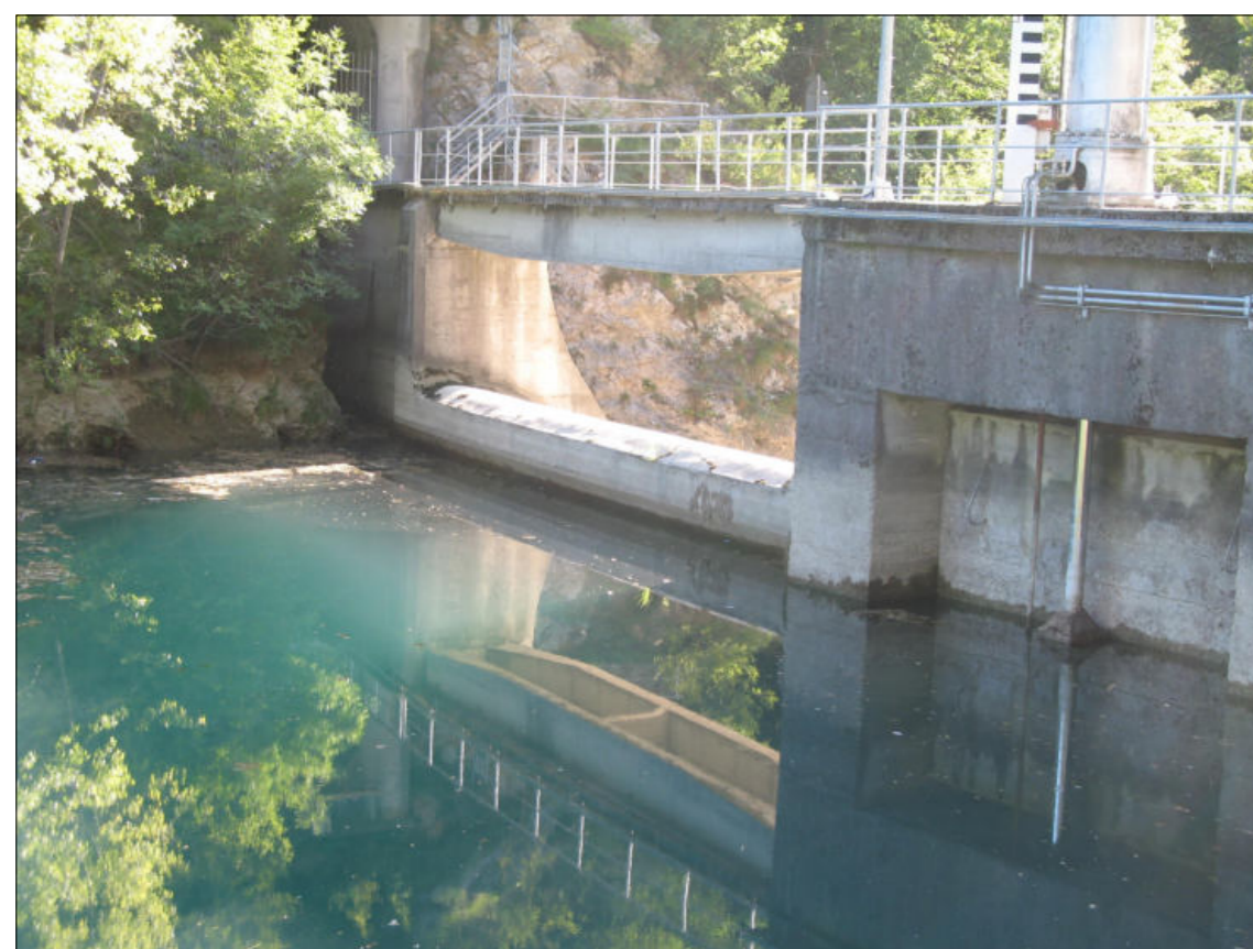
VISTA DA MONTE DELLA PASSERELLA DA SOSTITUIRE
