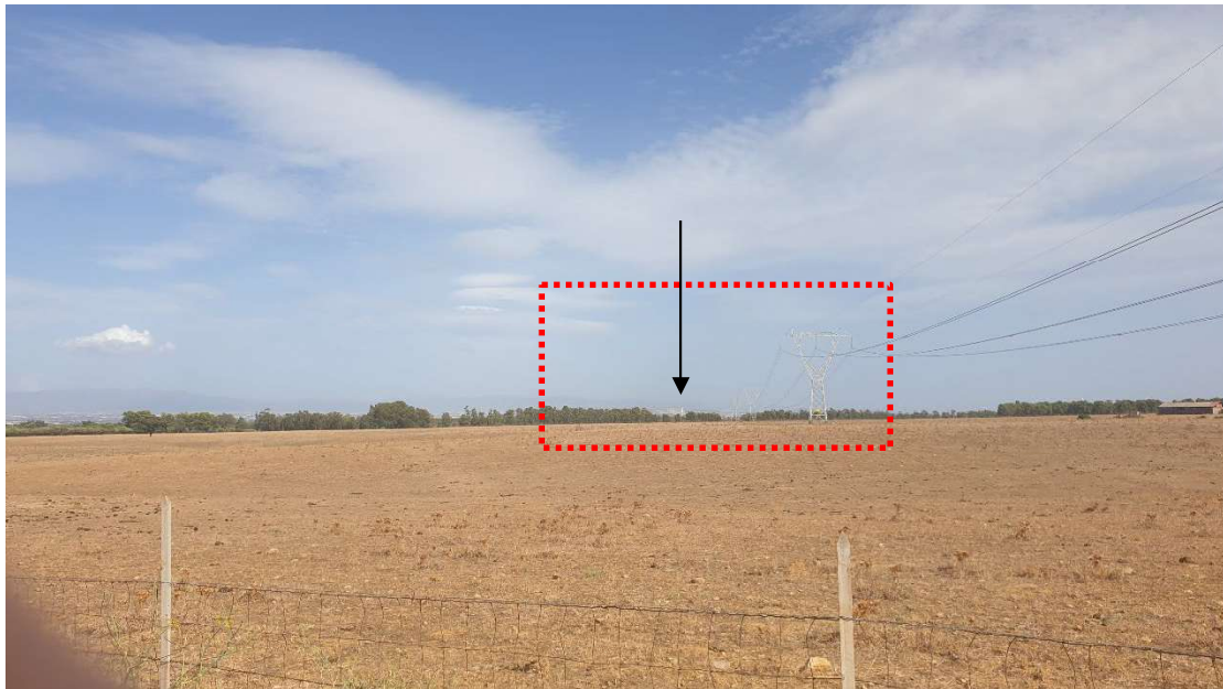
Punto di scatto n.7. Con la freccia viene indicata la torre piezometrica presente nei pressi dell'area di progetto.
