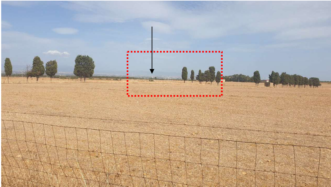
Punto di scatto n.6. Con la freccia viene indicata la torre piezometrica presente nei pressi dell'area di progetto.
