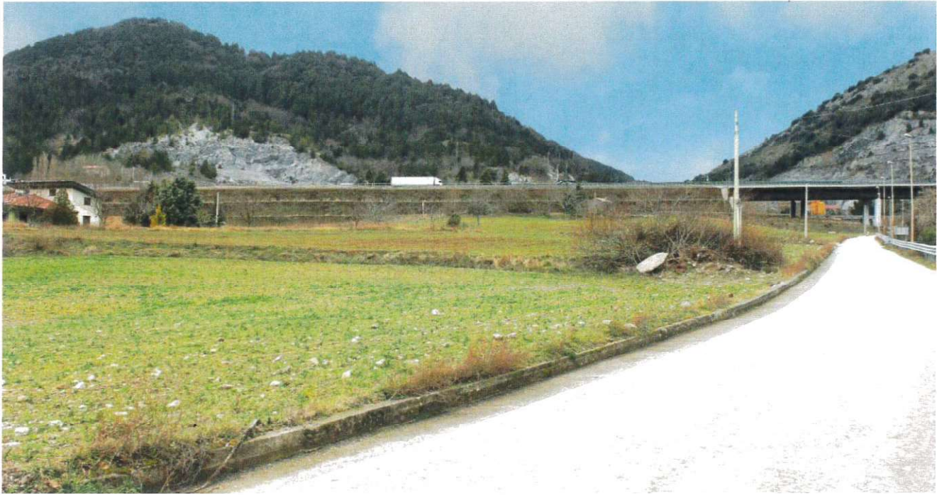
Rampa 2-2 di uscita dalla carreggiata sud_Stato ante-operam
