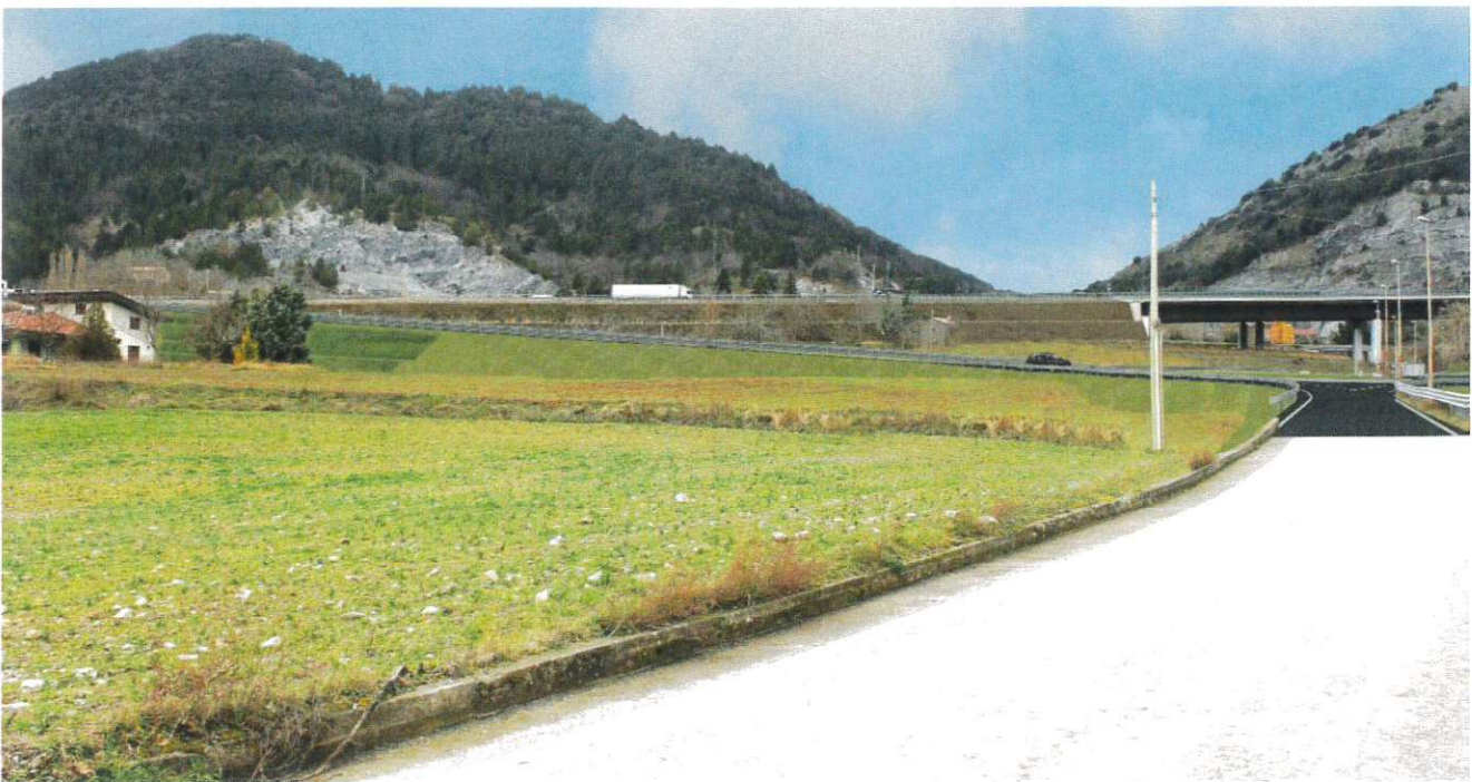
Rampa 2-2 di uscita dalla carreggiata sud_Stato post-operam
