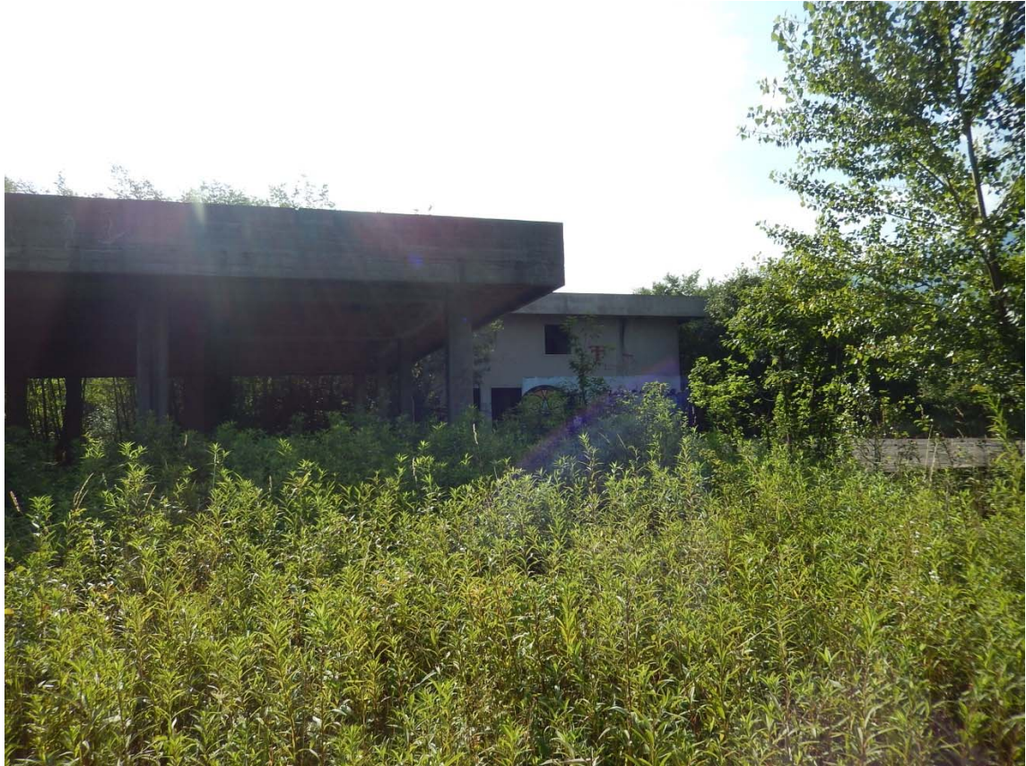
Figura 1 – Edifici esistenti non completati che saranno oggetto di demolizione
