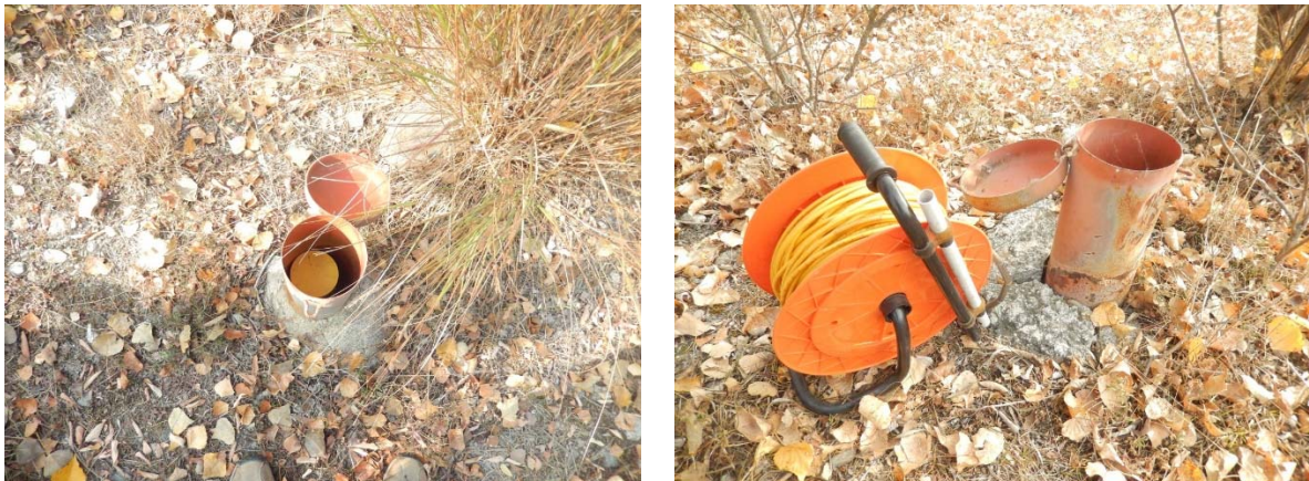
Figura 40 – Piezometri in sito
