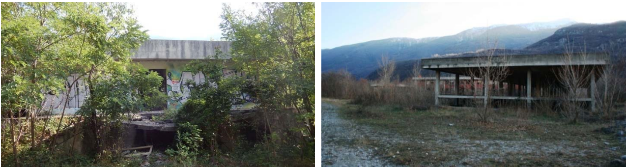
Figura 10 – Area di progetto con edifici incompiuti in stato di abbandono
