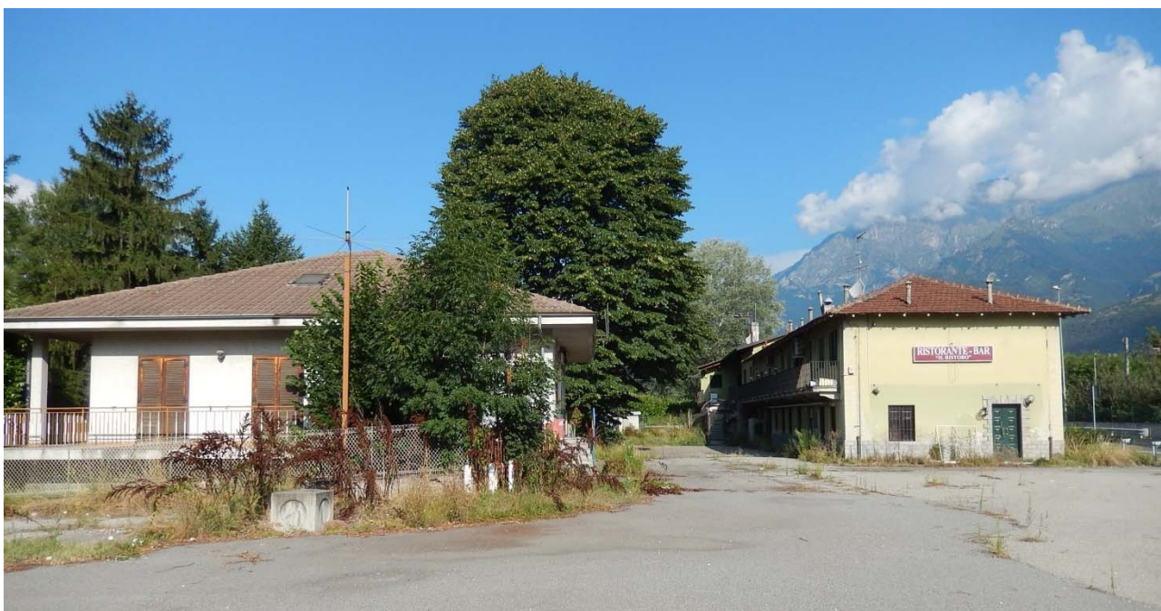
Figura 15 – Gli edifici più prossimi al perimetro dell'autoporto lungo la SS 25
