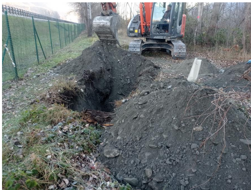
Foto2 : attività di prelievo campioni dai cumuli escavati alle profondità di interesse
