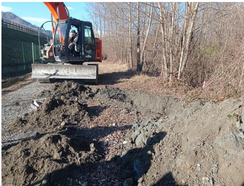
Foto1 : attività di riapertura pozzetti esplorativi eseguita in data 30/11/21 e 01/12/21
