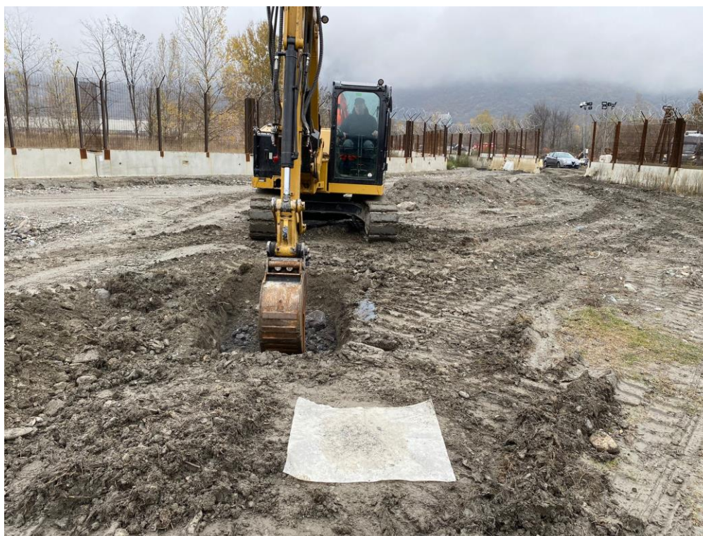
Foto2 : attività di prelievo campioni dai cumuli escavati alle profondità di interesse
