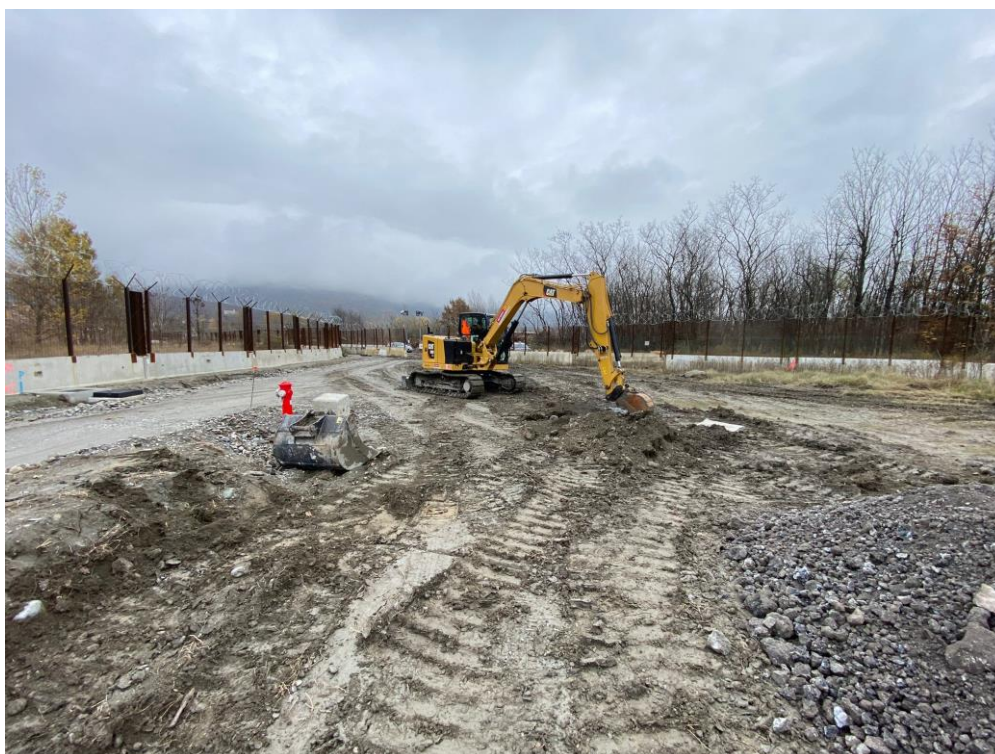
Foto 1 : attività di realizzazione pozzetti esplorativi SPE1 e SPE2 eseguita in data 22/11/21
