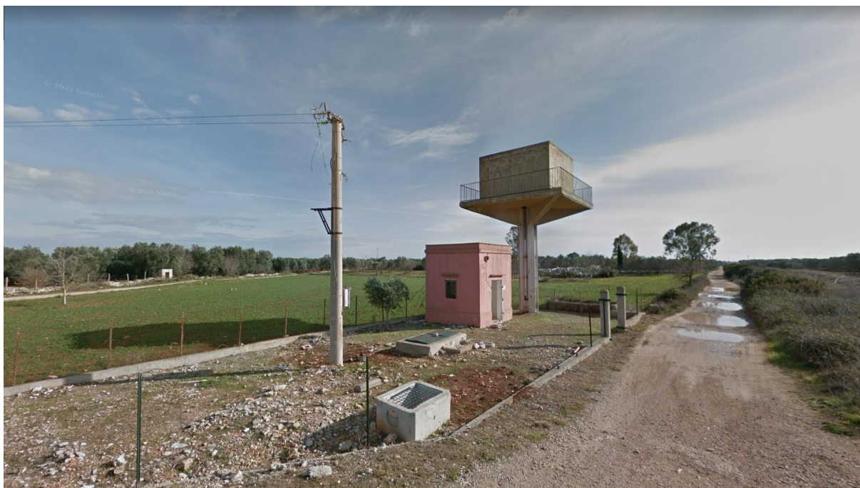
Figura 4.88: Materiale fotografico n. 4 – Punto di scatto D.
