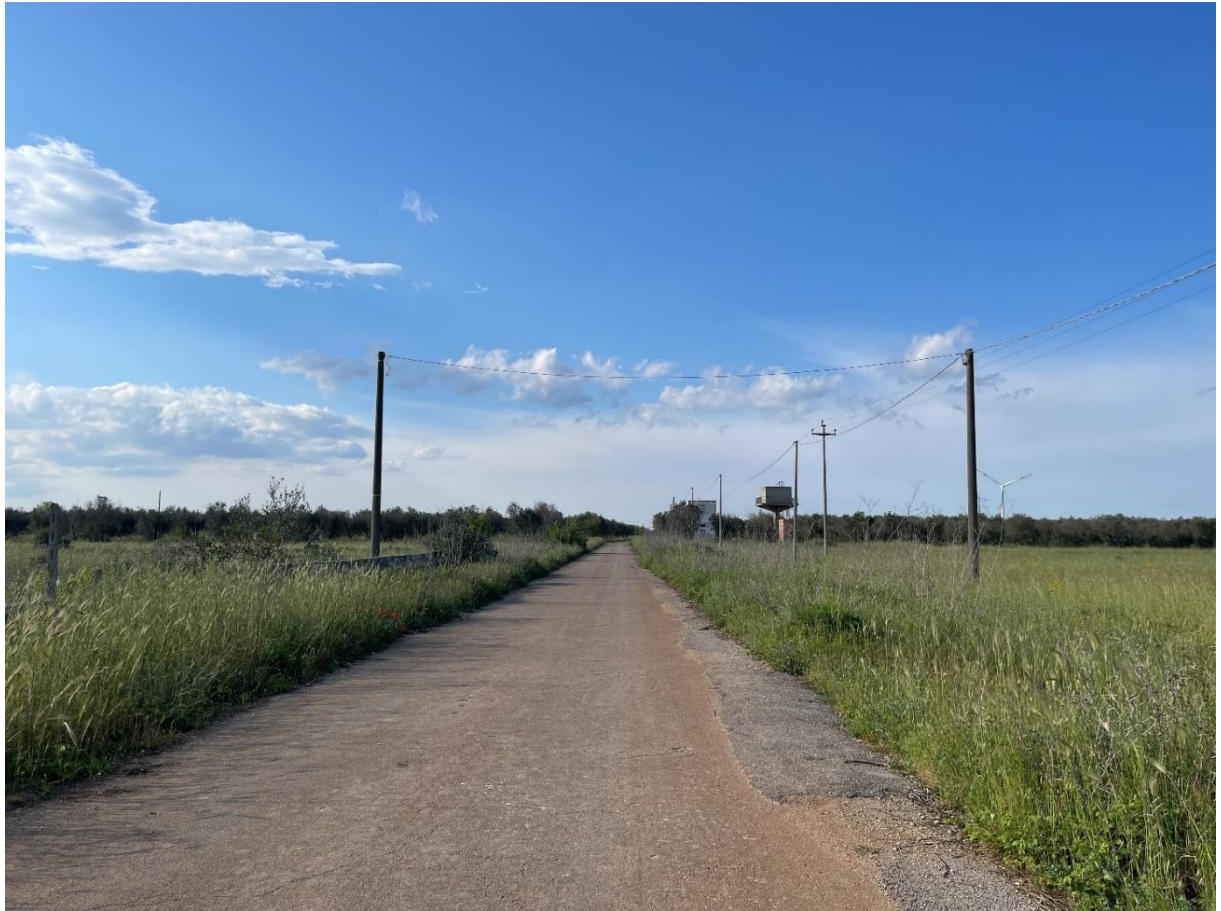
Figura 4.79: Materiale fotografico n. 1 – Punto n. A.
