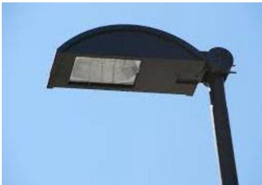
Figura 4.4: Esempio di apparecchio completamente schermato (full-cut-off).
