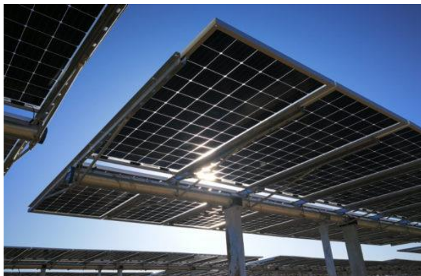
Figura 2.8 Esempio di struttura a tracker monoassiale
