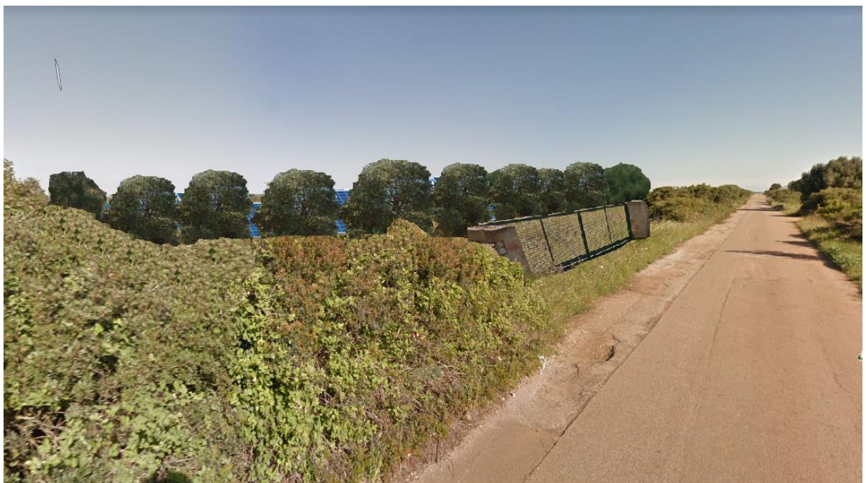
Figura 4.16.: Visuale Area Nord (Sezione A) – Punto di scatto C. – Stato di Progetto
