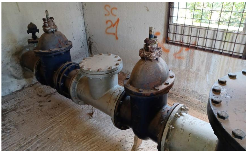
Figura 3.2: Foto di uno dei punti di adduzione idrica collegato alla rete del Consorzio di Bonifica.
