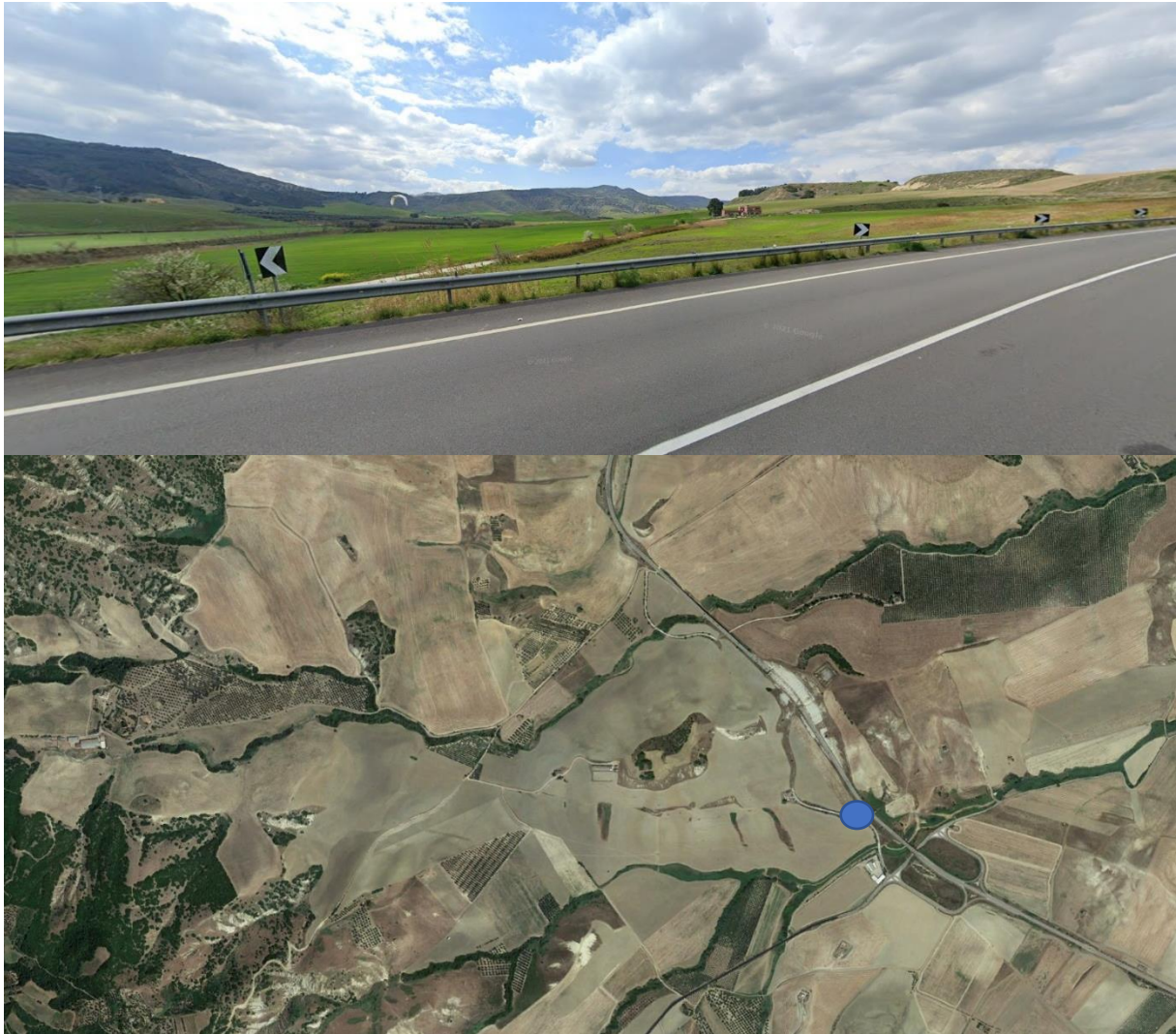
Fig. 7.4- Vista dell'area del parco dalla SP3 in direzione nord-ovest (fonte Google)
