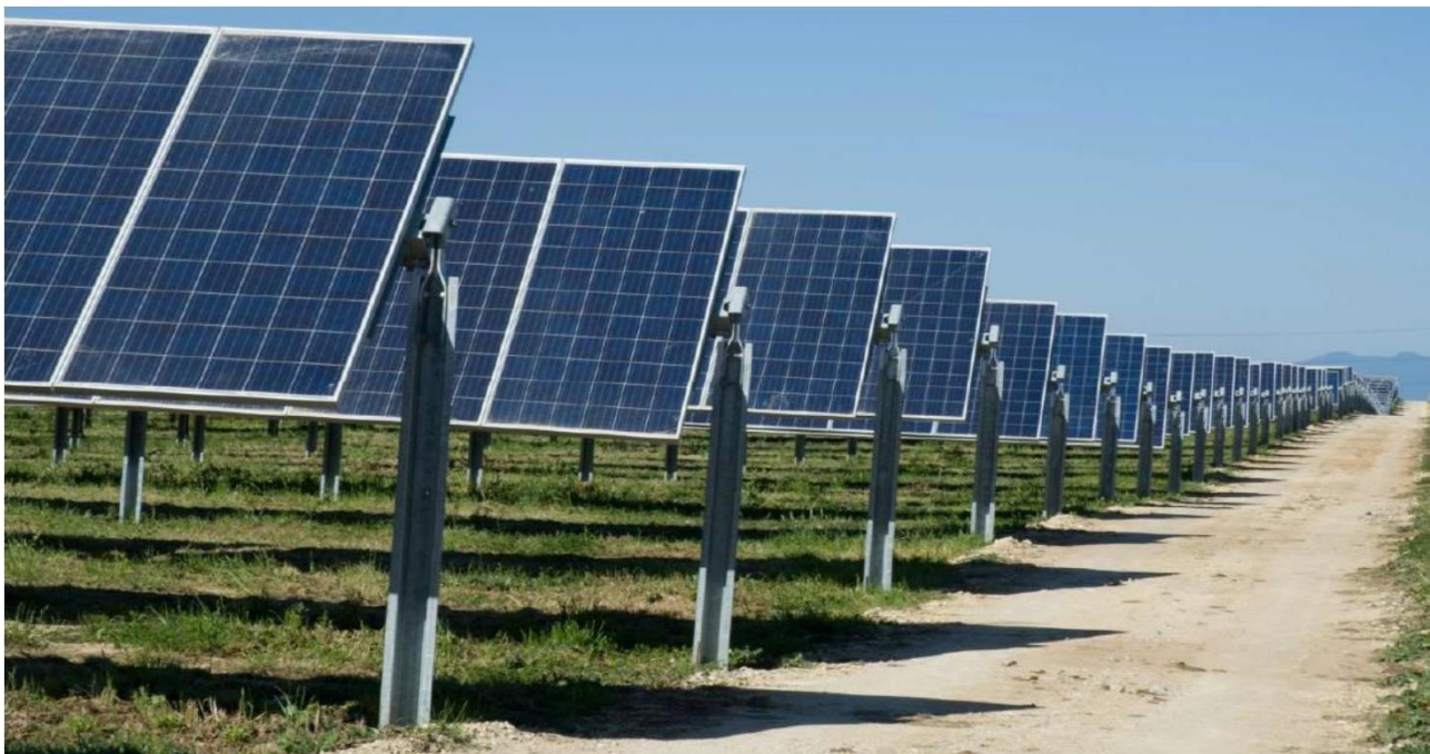
Fig. 3.2 – Immagine esemplificativa di inseguitori mono-assiali e moduli FV
