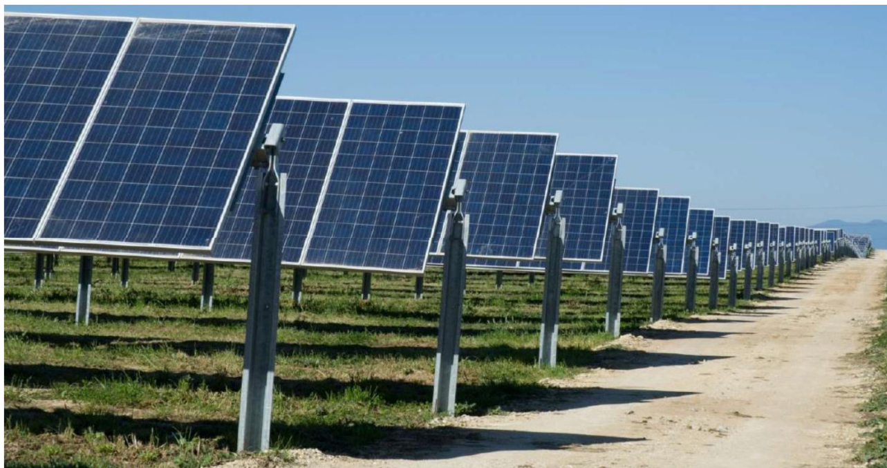
Fig. 3.5 - Moduli fotovoltaici montati su struttura analoga a quella di progetto
