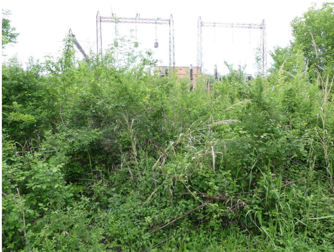
Figura 8 - Dettaglio della vegetazione arbustiva presente tra il sostegno e la CP di San Lazzaro
