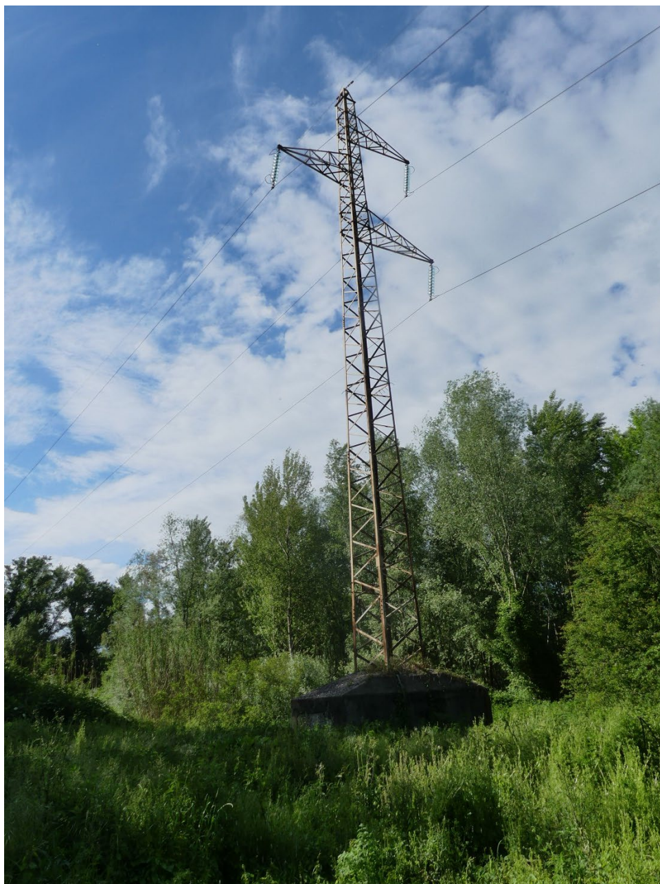
Figura 21 - Foto scattata dal sentiero di accesso verso il sostegno P2; si nota che la radura in cui ricade il sostegno è caratterizzata dalla dominanza di Urtica dioica e altre essenze erbacee eliofile di rapida colonizzazione
