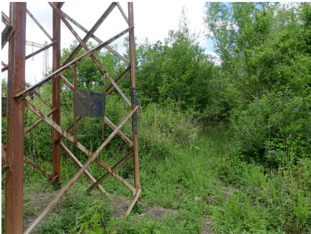
Figura 16 - Foto scattata dal sostegno verso il sentiero di accesso pedonale
