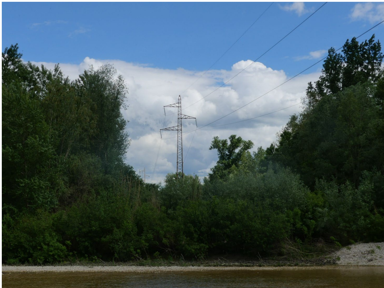
Figura 56 - Vista del sostegno P2 dal Fiume Metauro, si nota la presenza della fitta fascia di vegetazione arbustiva
