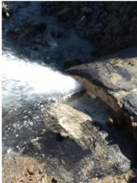
Figura 1 - Perdita tipo da giunto.
