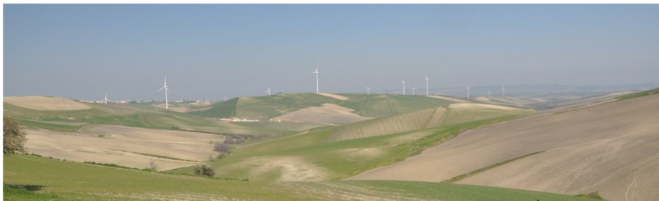
Figura 6-14: Aerogeneratori visibili nell'areale di studio
