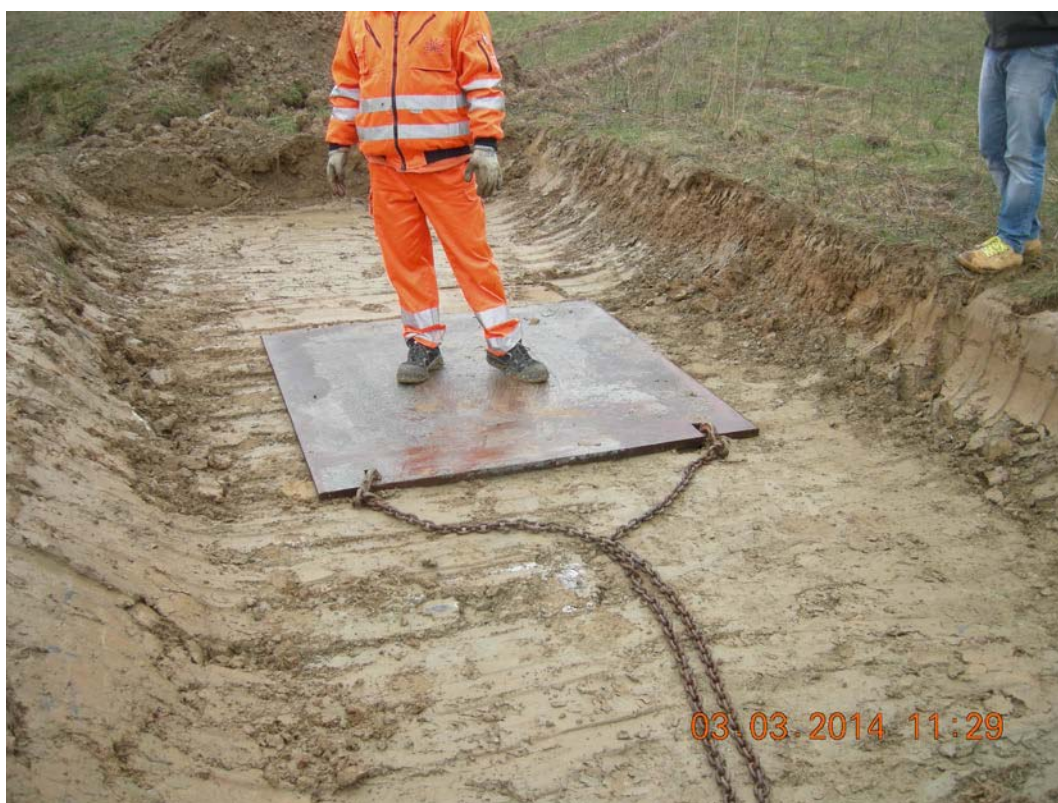
Figura 2 – Posa della piastra di carico dopo lo scotico superficiale
