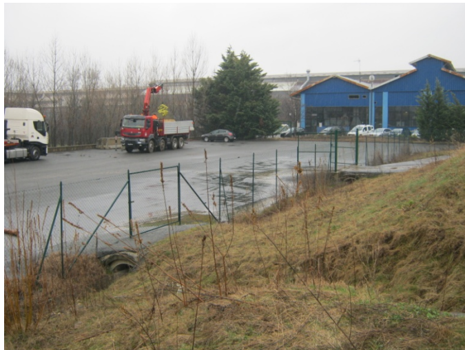
area per allestimento baraccamenti di cantiere
