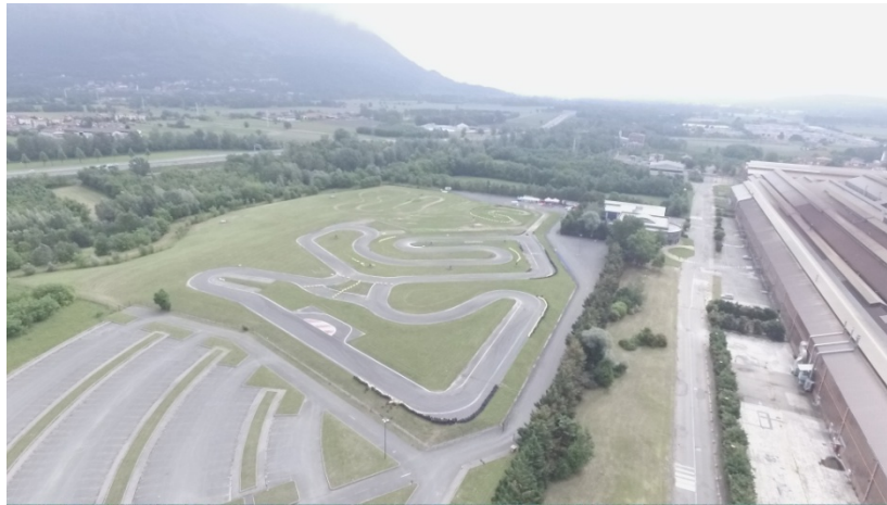
area oggetto di scarifica e scotico
