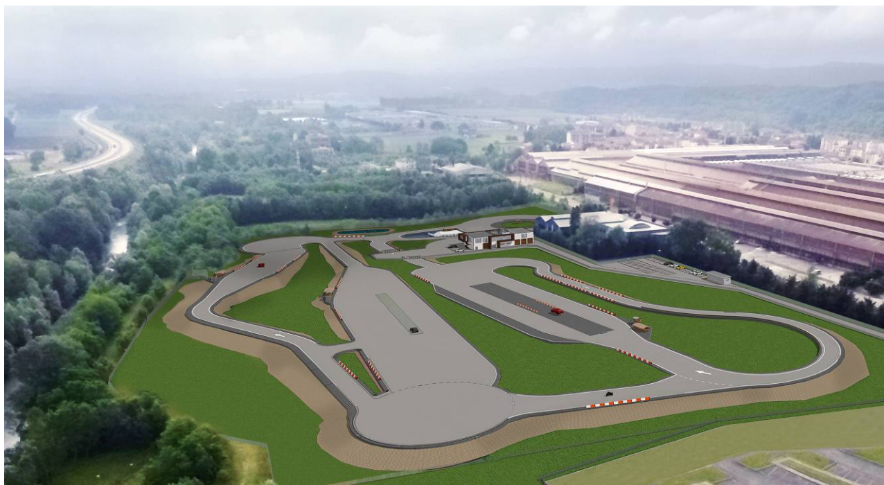
Vista aerea (orientamento Nord Ovest-Sud Est) del sito oggetto dell'intervento - in progetto
