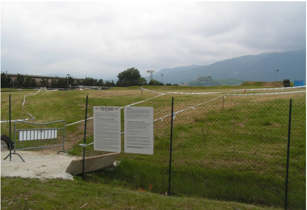
Zona sopraelevata di bonifica all'interno dell'area di intervento
