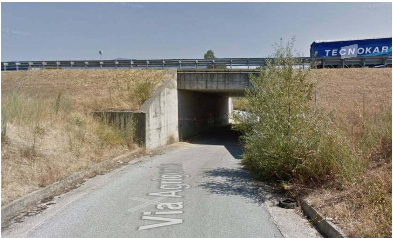
Figura 16: Vista imbocco ovest
