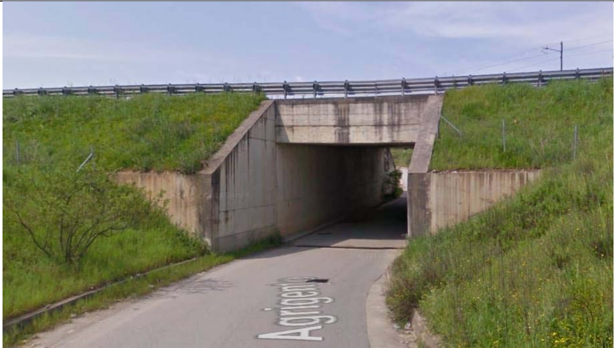
Figura 15: Vista imbocco est
