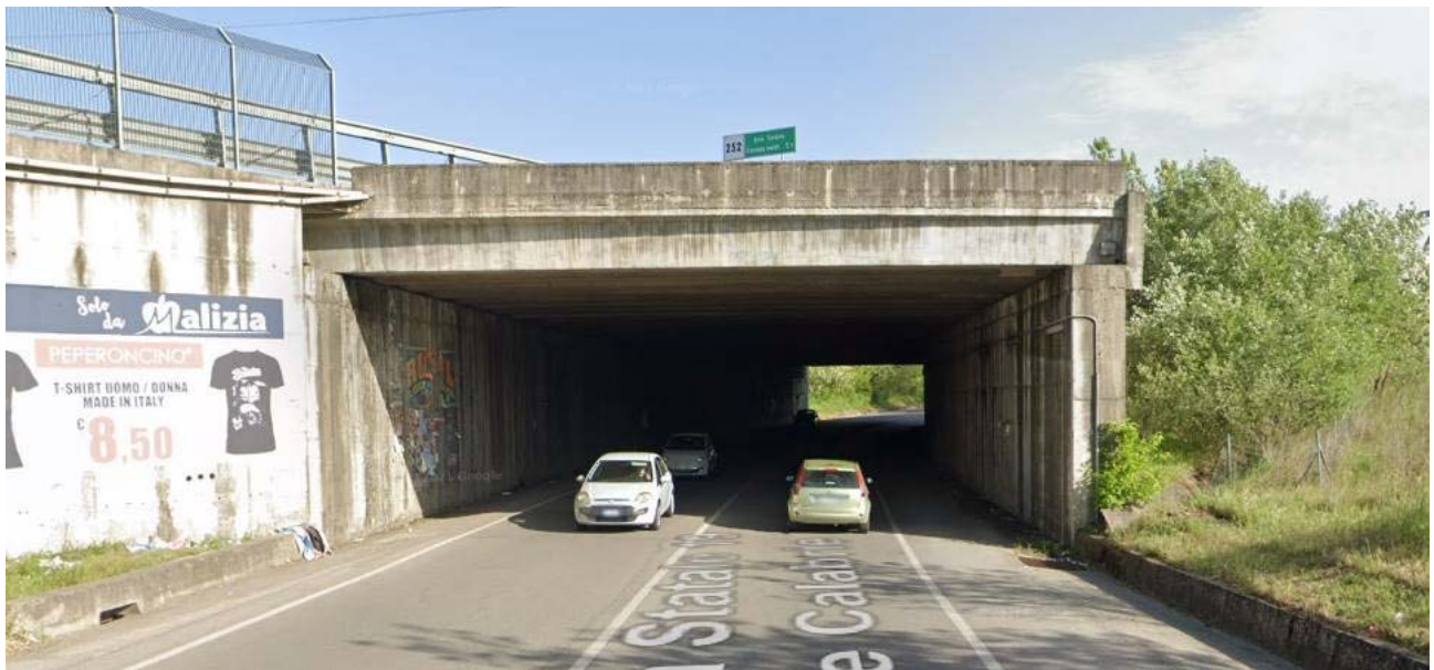
Figura 11: Vista imbocco nord
