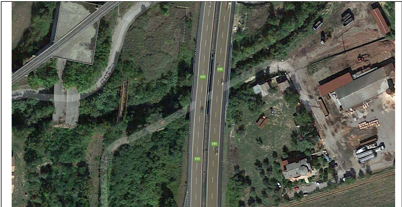
Figura 7: Vista aerea con individuazione dell'opera
