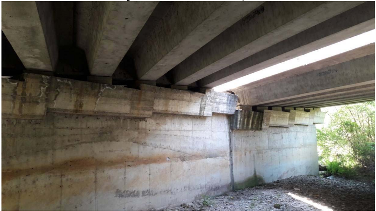
Figura 8: Vista intradosso impalcato
