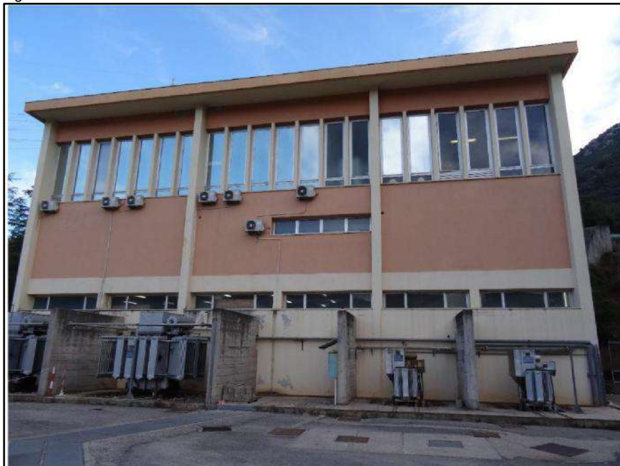
Figura 3.2.2d Edificio della centrale – vista da Sud-Ovest
