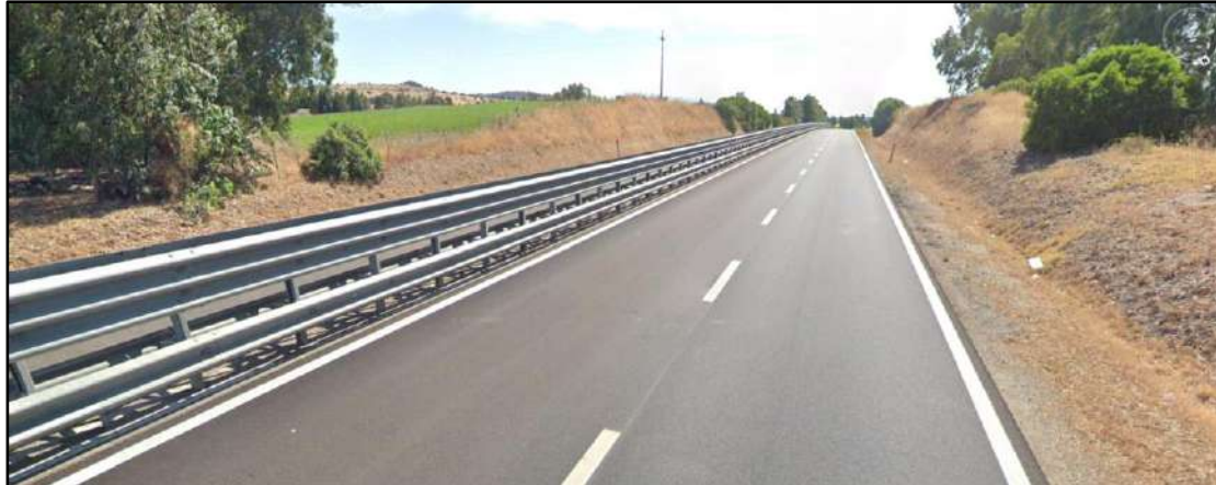
Figura 4.2.9e Vista SS131 dnc presso lo svincolo di Ottana
