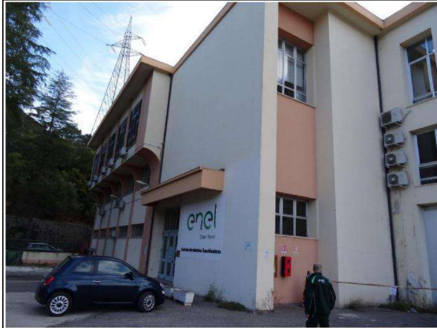
Figura 3.2.2e Edificio della centrale – vista da Sud
