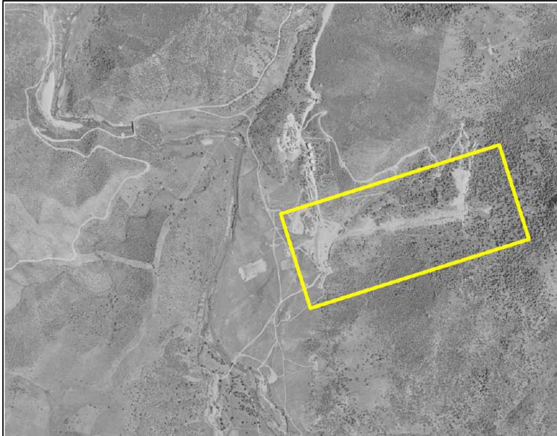
Figura 4.2.3.1f Foto aerea del 1960 antecedente alla costruzione dello sbarramento. Si notano gli scavi relativi alla realizzazione della centrale e della condotta forzata (riquadro giallo).
