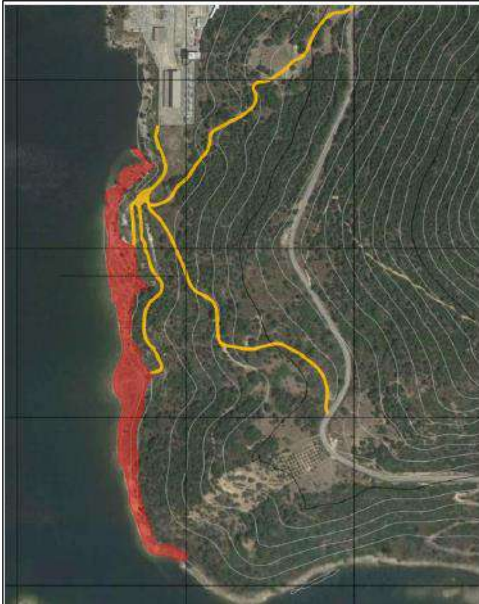
Figura 3.4.3a Sistemazione dello smarino lungo l'arenile di una porzione di arenile del lago di Cucchinadorza e le strade sterrane interne alla proprietà
