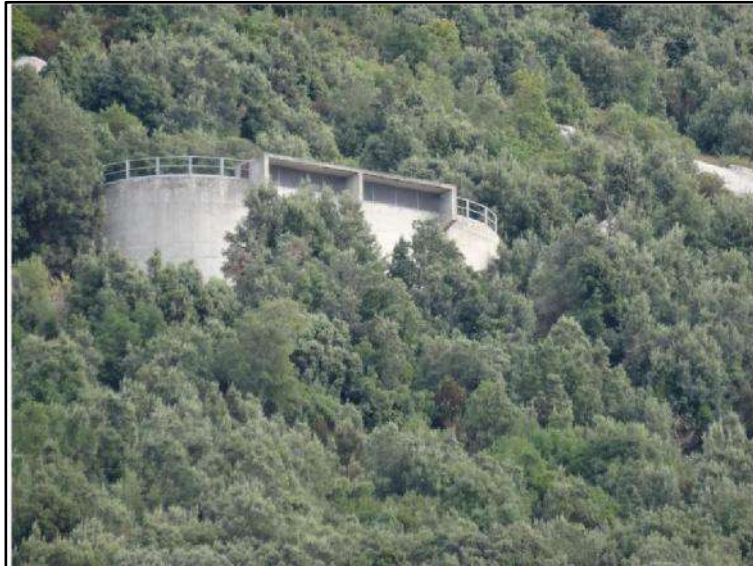
Figura 3.2.2a Parte sommitale del pozzo di espansione di monte
