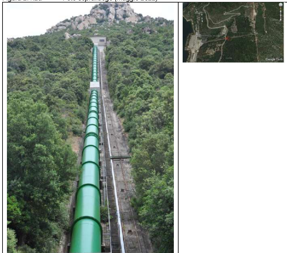
Figura 2.1.2a Foto sopralluogo (maggio 2022)
